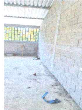
Foto 2: Reparación de muro de block
