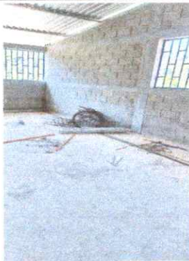
Foto 3: Reparación de muro de Block
