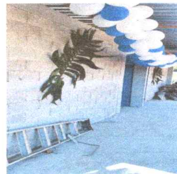
Foto 6: Reparación de muro de block
