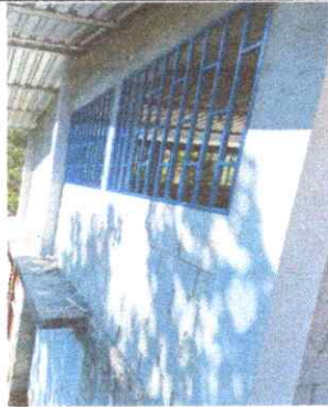
Foto 1: Reparación de muro de block
