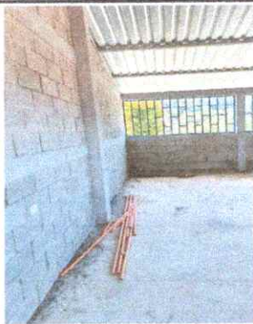
Foto 5: Reparación de muro de Block
