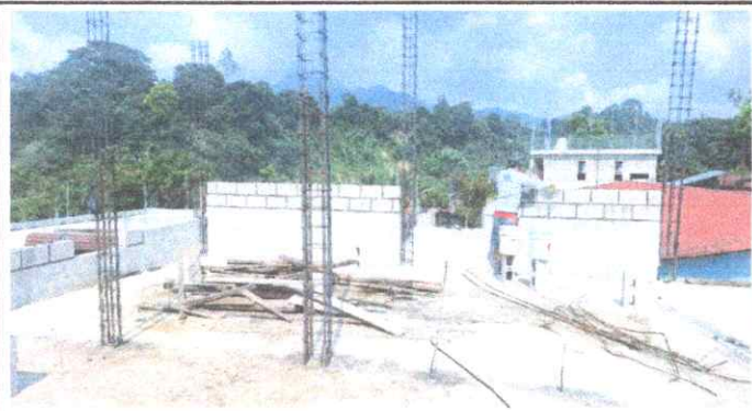
Foto 1: Reparación de muro de block
