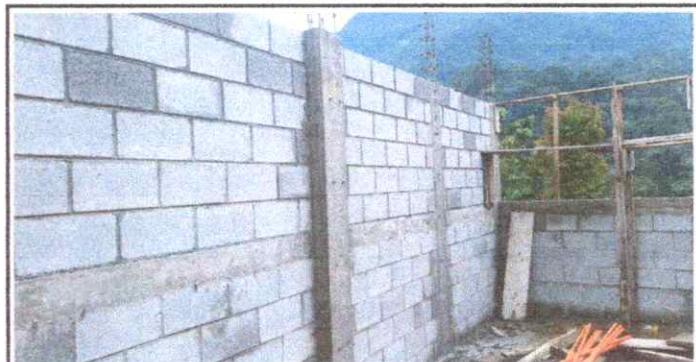
Foto 6: Reparación de muro de block
