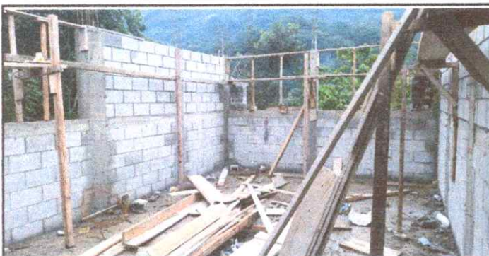
Foto 5: Reparación de muro de Block
