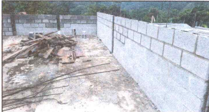
Foto 2: Reparación de muro de block
