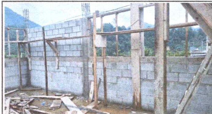
Foto 4: Reparación de muro de Block
