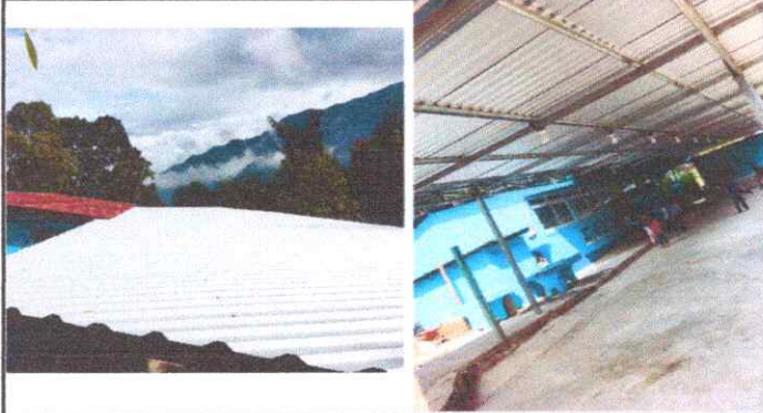
Foto1: Sustrucción de lámina, por lámina troquelada aluzinc calibre 26-168 mts. Cuadrados.
