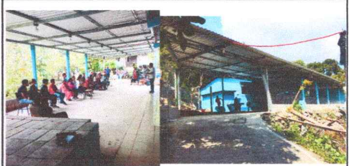
Foto 2: Sustrucción de lámina, por lámina troquelada aluzinc calibre 26-168 mts. Cuadrados.
