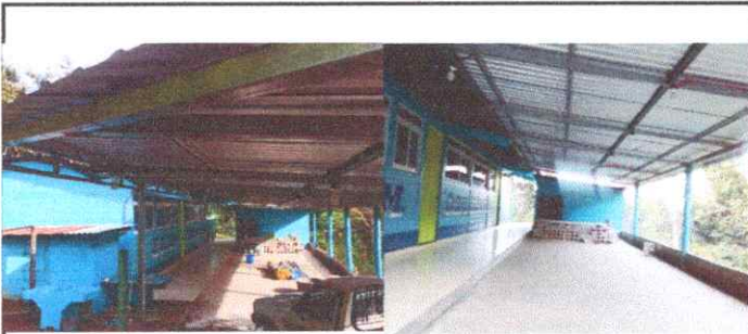
Foto 3: Sustrucción de estructura de soporte de madera, por metal, 168 mts. Cuadrados.
