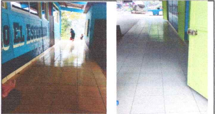
Foto 4: Sustrucción de piso cerámico, 42 mts. Cuadrados.
