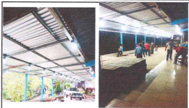
Foto 8: Reparación del sistema eléctrico (Sustitución de focos, plafoneras, interruptores, tomacorrientes, filpones, cableado, ducto eléctrico mas acciseros).
