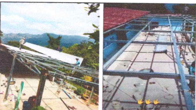
Foto 3: Sustitución de estructura de soporte de madera, por metal, 168 mts. Cuadrados.
