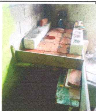
Foto 9: Reparación de cocina (Sustrucción de estufa rural completa incluye chimenea y plancha de metal; Instalación de azulejo en estufa rural).
