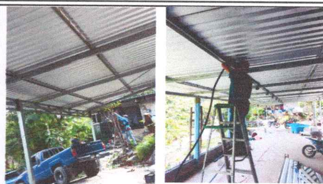
Foto 8: Reparación del sistema eléctrico (Sustrucción de focos, plafoneras, interruptores, tomacorrientes, flipones, cableado, ducto eléctrico mas accesorios).
