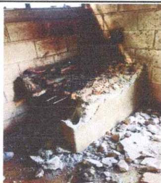
Foto 9: Reparación de cocina (Sustrucción de estufa rural completa incluye chimenea y plancha de metal; Instalación de azulejo en estufa rural).
