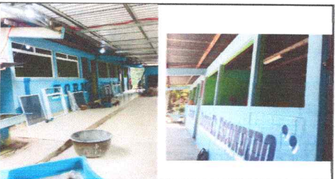
Foto 5: Sustitución de ventanas de metal a material PVC mas vidrio, 19 mts. Cuadrados.
