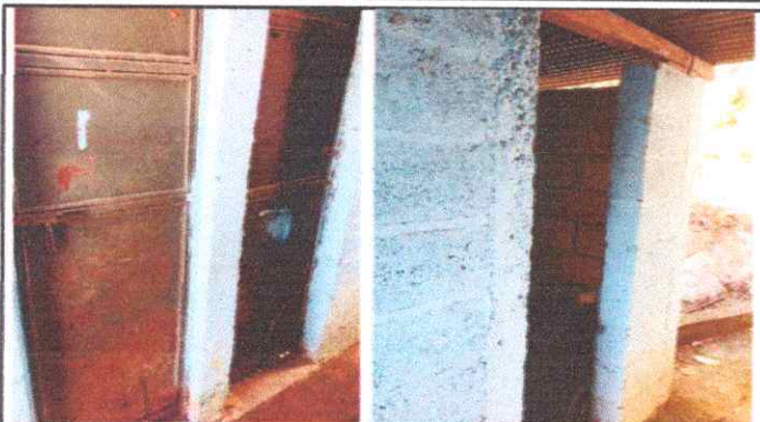
Foto7: Sustrucción de puertas en servicios sanitarios (2 unidades).
