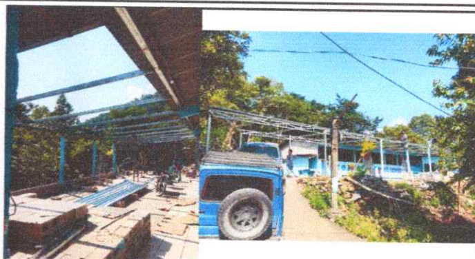
Foto 2: Sustitución de lámina, por lámina troquelada aluzinc calibre 26-168 mts. Cuadrados.
