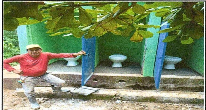
Foto 2: Instalacion de inodoros
