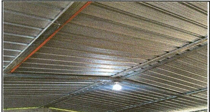
Foto 4: Reparacion de sistema electrico
