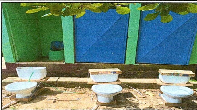
Foto 2: Instalacion de inodoros
