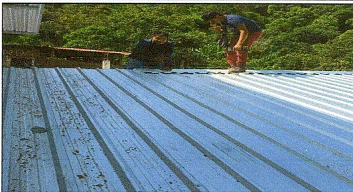
Foto 1: instalacion de lamina
