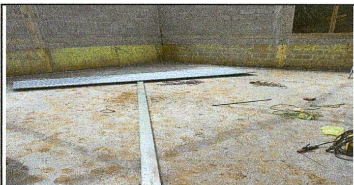
Foto 5: sustitucion de piso de torta de concreto
