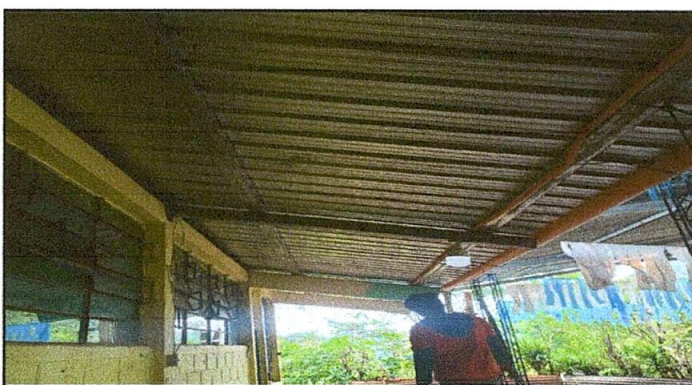
Foto 4: Reparacion de sistema electrico
