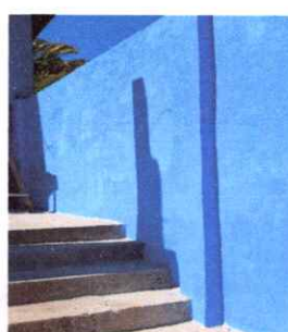
Foto 6: Repello en muro perimetral
