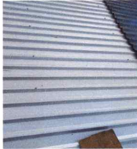
Foto1: Sustitución de lámina, por lámina troquelada Aluzinc calibre 26
