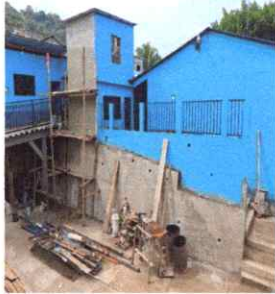
Foto7: Aplicación de repello en muro de contención
