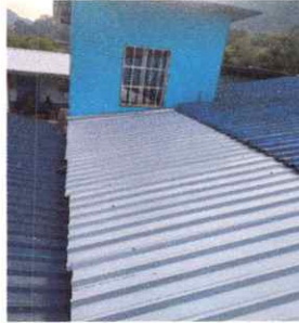
Foto1: Sustitución de lámina, por lámina troquelada Aluzinc calibre 26
