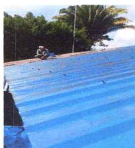
Foto 3: Impermeabilización y pintura de lámina.
