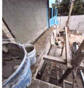
Foto7: Aplicación de repello en muro de contención
