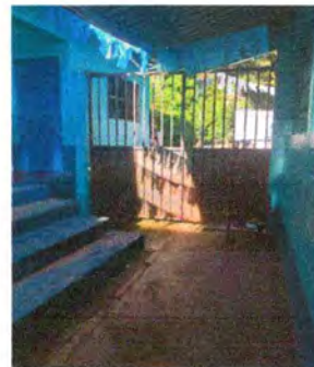
Foto 10: Mantenimiento a portón de metal
