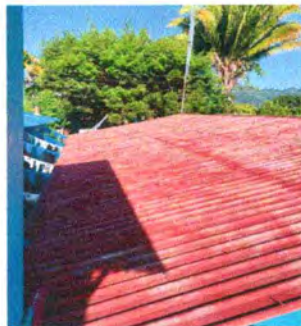
Foto 3: Mantenimiento de lámina. (Aplicación de pintura anticorrosiva)
