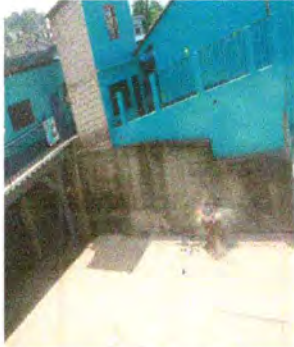
Foto 7: Reparación muro de contención
