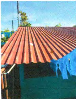
Foto 3: Mantenimiento de lámina. (Aplicación de pintura anticorrosiva)
