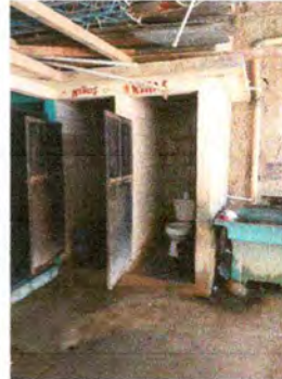
Foto 8: Reparación de azulejo en baño.
