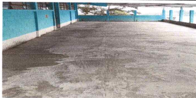
Foto 5: reparación de piso de torta de concreto
