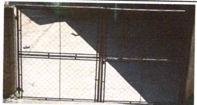
Foto 4: Cambio De Porton
