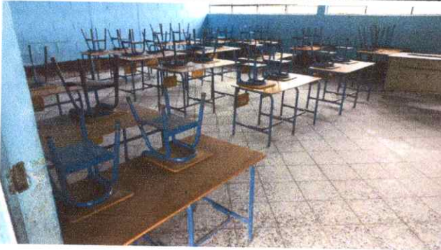
Foto1: Sustitución de piso
