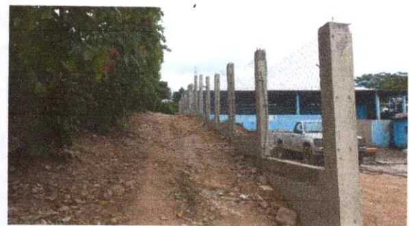
Foto 6: Reparación de muro perimetral
