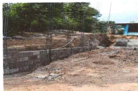
Foto 6: Reparación de muro perimetral
