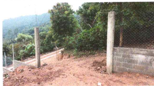
Foto 4: Cambio De Porton
