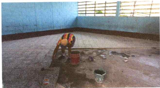
Foto1: Sustitución de piso
