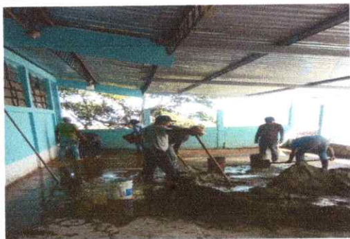
Foto 5: reparación de piso de torta de concreto
