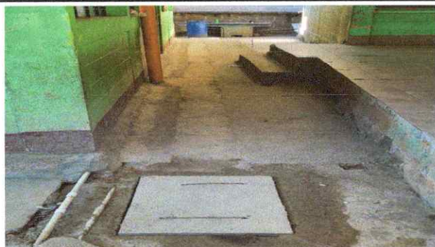
Foto 5: Reparación de red de drenaje
