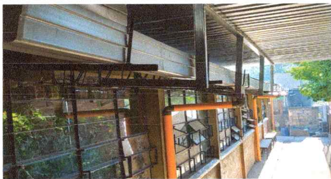
Foto 3: Sustitución de canal de metal
