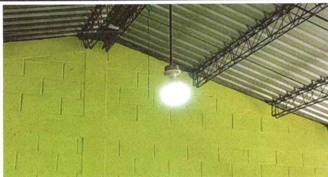
Foto7: Sustitución de lamparas tipo LED
