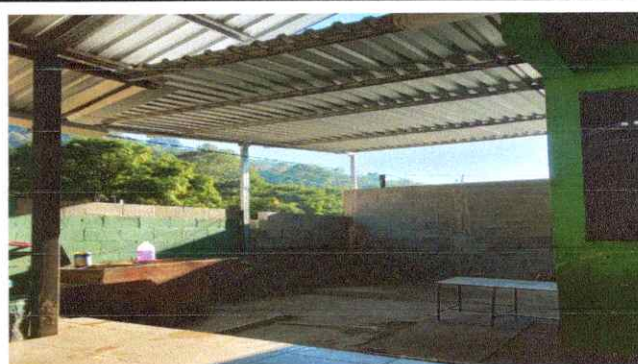
Foto 2: Estructura de techo para pila
