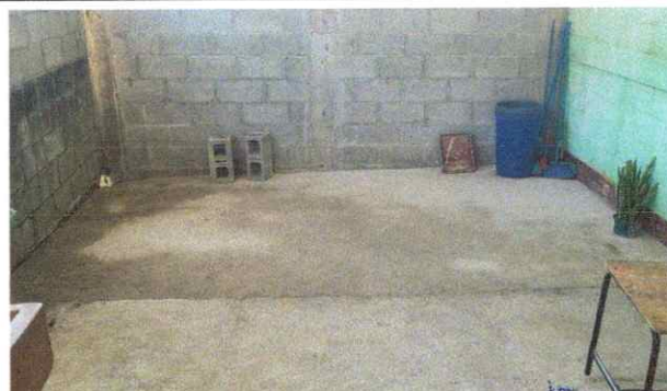
foto 10: Reparación de planchas de concreto de patio
