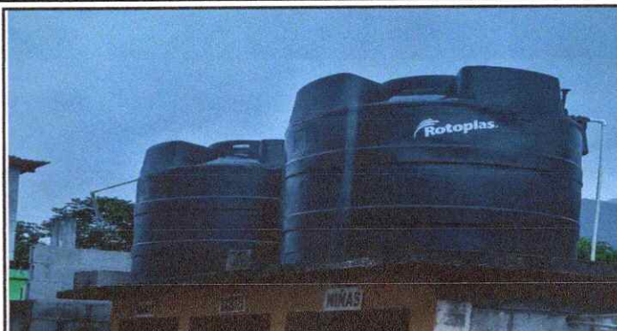
Foto 8: Reparación y mantenimiento de depósitos de agua
