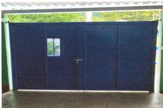
Foto 9: Sustitución de porton de metal
