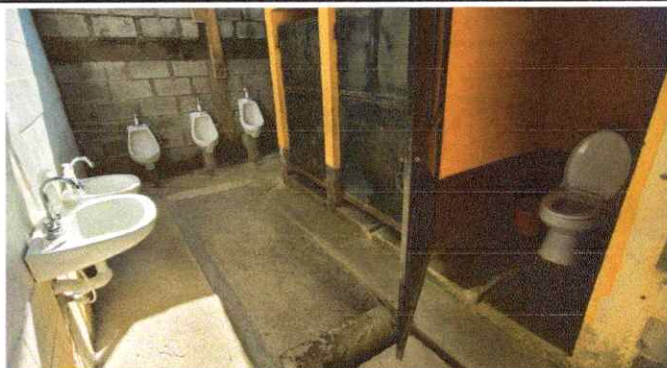
Foto 4: Sustitución de inodoros, Lavamanos y Mingitorios
