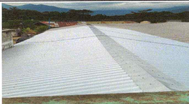
Foto1: Sustitución de lámina troquelada calibre 26
