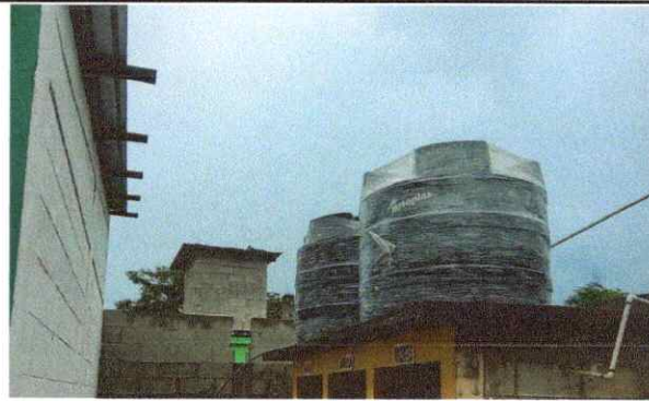
Foto 8: Reparación y mantenimiento de depósitos de agua
