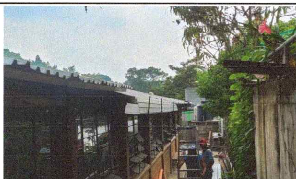
Foto 3: Sustrucción de canal de metal
