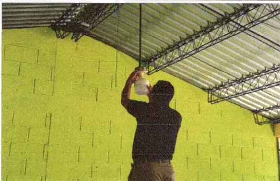
Foto7: Sustitución de lamparas tipo LED
