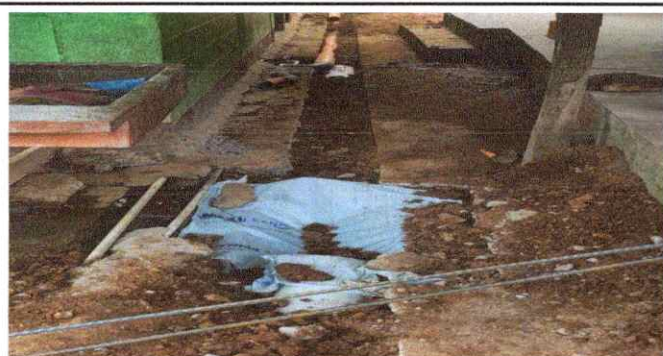
Foto 5: Reparación de red de drenaje
