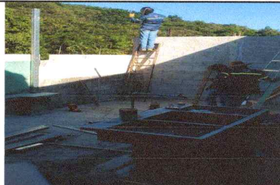
Foto 2: Estructura de techo para pila
