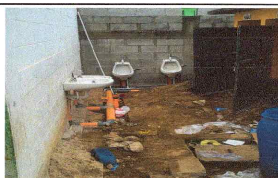
Foto 4: Sustrucción de inodoros, Lavamanos y Mingitorios
