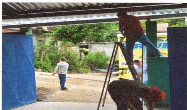
Foto 9: Sustitución de porton de metal
