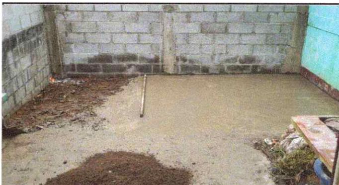
foto 10: Reparación de planchas de concreto de patio
