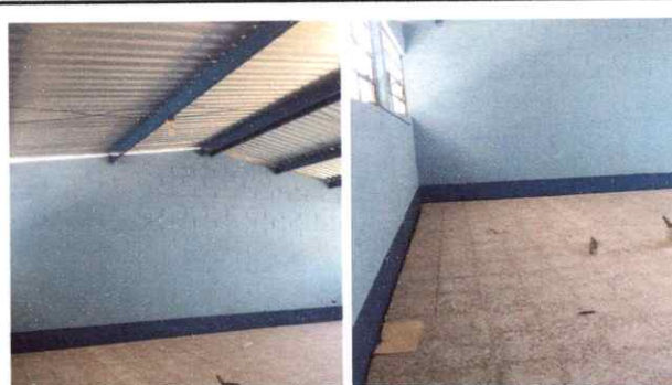
FOTOGRAFIA No. 2 SUSTITUCION DE PISO
