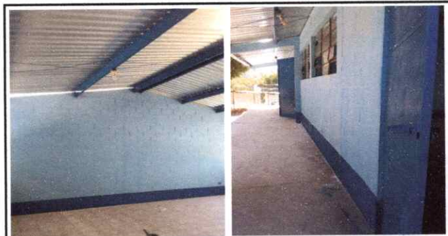
FOTOGRAFIA No. 3 SUSTITUCION SISTEMA ELECTRICO
