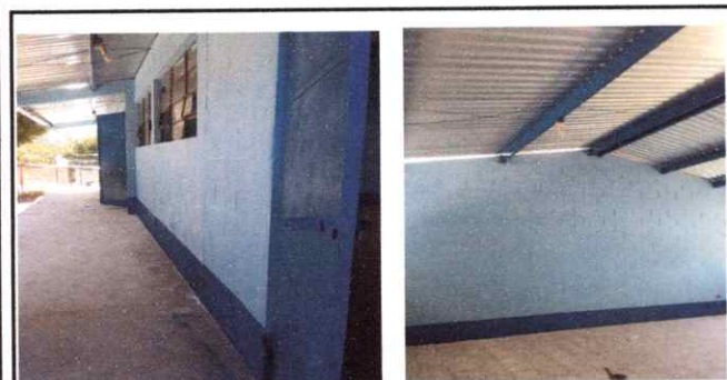
FOTOGRAFIA No. 5 SUSTITUCION SISTEMA ELECTRICO
