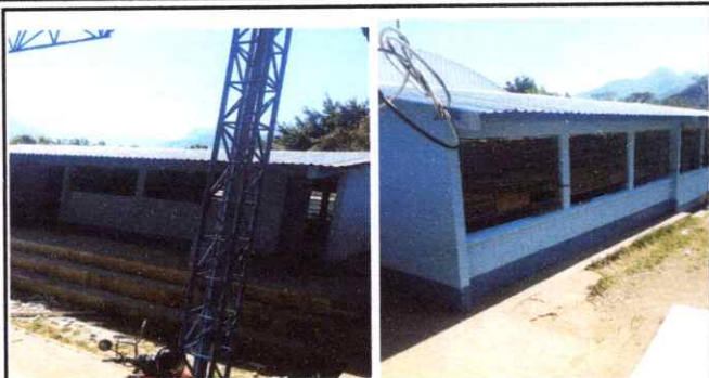
FOTOGRAFIA No. 1 SUSTITUCION DE LÁMINA
