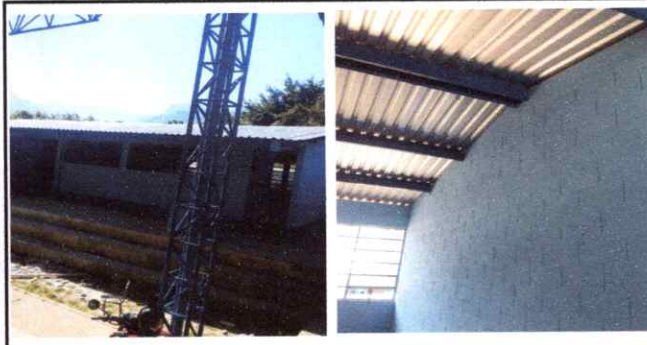
FOTOGRAFIA No. 4 SUSTITUCION DE LAMINA
