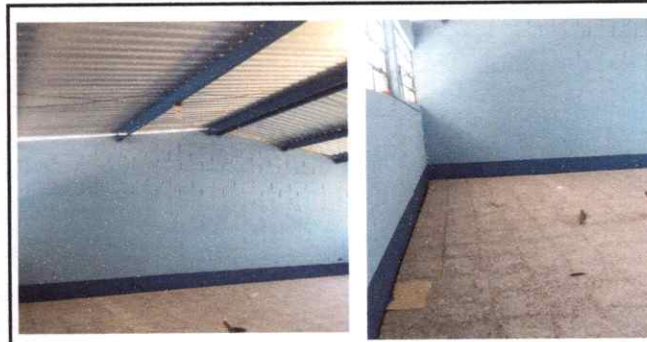
FOTOGRAFIA No. 6 SUSTITUCION DE PISO
