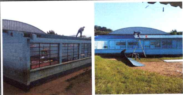
FOTOGRAFIA N.4 SUSTITUCION DE LAMINA
