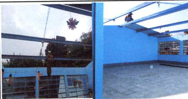
FOTOGRAFIA No. 3 SUSTITUCION SISTEMA ELECTRICO
