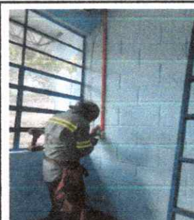
Foto 6: SUSTITUCION DE CABLEADO ELECTRICO
