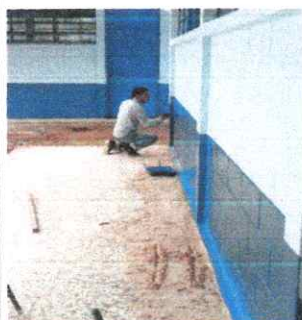
Foto 5: SUSTITUCION DE PINTURA Y CIRCULACION. SUSTITUCION DE PLANCHA DE CONCRETO DE PATIO
