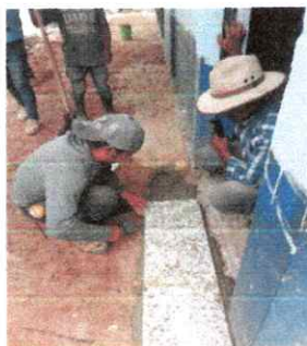
Foto 3: SUSTITUCION CHAPAS EN MAL ESTADO. SUSTITUCION PISO.
