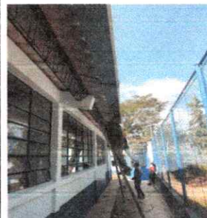
Foto 4: SUSTITUCION DE CANALES. SUSTITUCION BANQUETA.
