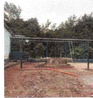
Foto 2: SUSTITUCION DE SOPORTE ESTRUCTURA DE TECHO
