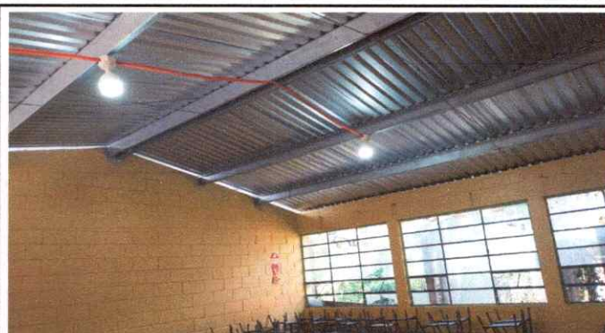
Foto 8: Mantenimiento a estructura de soporte de metal
