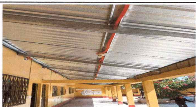
Foto 10: Sustitución de elementos de fijación
