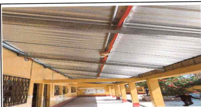
Foto 3: Sustrucción de estructura de soporte de madera, por metal
