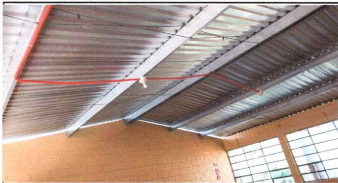
Foto7: Mantenimiento a estructura de soporte de metal
