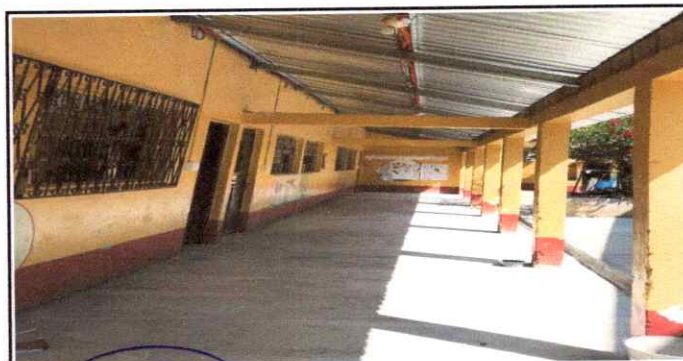
Foto 6: Reparación de piso de torta de concreto
