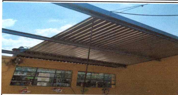
Foto 7: Mantenimiento a estructura de soporte de metal
