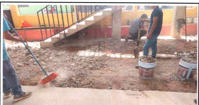
Foto 5: Reparacion de piso de torta de concreto
