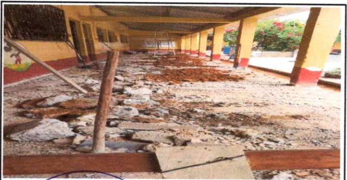
Foto 6: Reparacion de piso de torta de concreto
