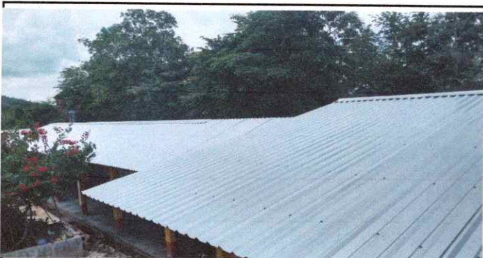
Foto 9: Sustitución de capote de lámina para lámina troquelada
