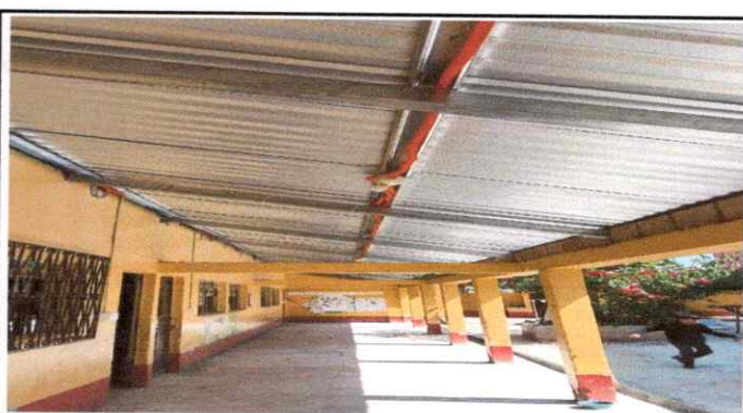
Foto 10: Sustitución de elementos de fijación
