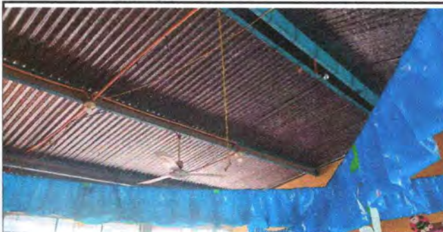
Foto 8: Mantenimiento a estructura de soporte de metal
