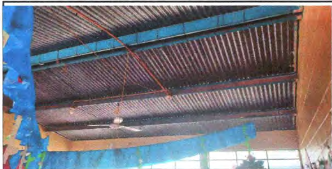
Foto 7: Mantenimiento a estructura de soporte de metal
