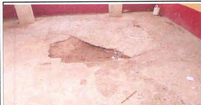
Foto 5: Reparación de piso de torta de concreto
