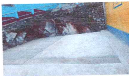
Foto 2: TERMINACION DE PISO DE TORTA DE CONCRETO
