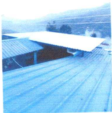
Foto 7: TERMINACION DE LAMINAS Y ESTRUCTURA DE SOPORTE
