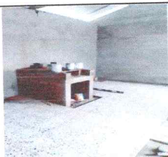
Foto 3: TERMINACION DE PISO
