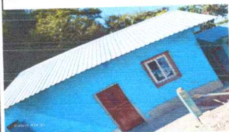
Foto 1: TERMINACION DE COCINA
