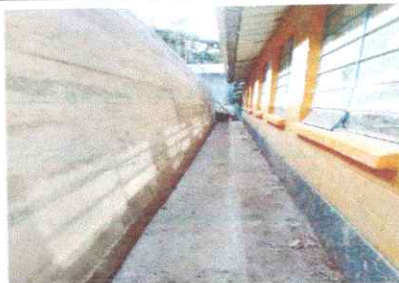
Foto 6: TERMINACION DE MURO DE CONTENCIÓN
