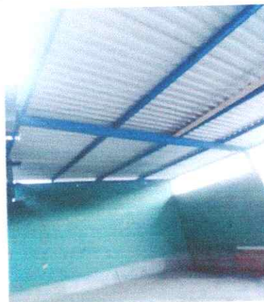
Foto 8: TERMINACION DE SUSTITUCION DE LAMINAS
