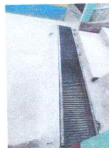
Foto 10: TERMINACION DE CUNETA (REJILLA)
