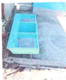
Foto 11: Sustitución de pila de cemento de dos lavadero
