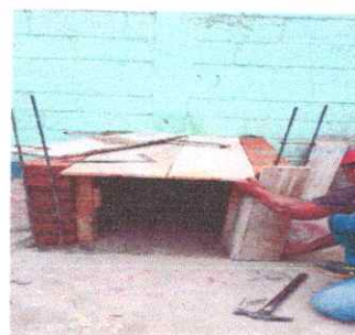
Foto 12: Reparación de estufa rural
