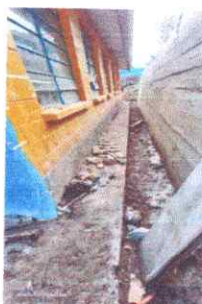
Foto 9: Reparación de cunetas
