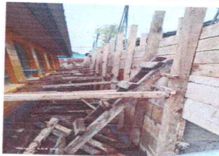
Foto 6: Reparacion de muro de contencion
