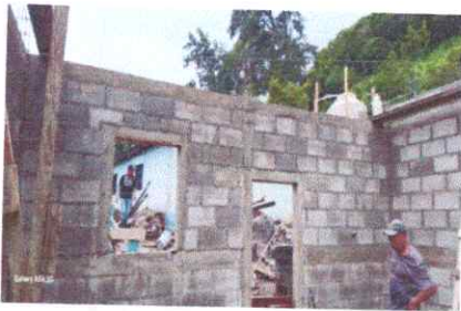
Foto 5: Reparacion de pared
