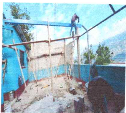
Foto 7: Sustitución de láminas y estructura de soporte
