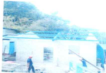
Foto 2: Colocando con la estructura
