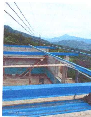
Foto 8: Sustitución de lámina
