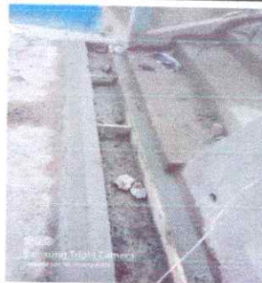
Foto 10: Reparación de cuneta (rejilla)
