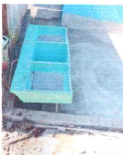
Foto 11: Sustitución de pila de cemento de dos lavadero
