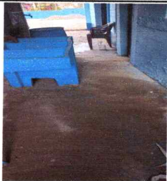
Foto 19: Reparación de piso de torta de concreto
