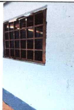
foto 22: mejoramiento de pared
