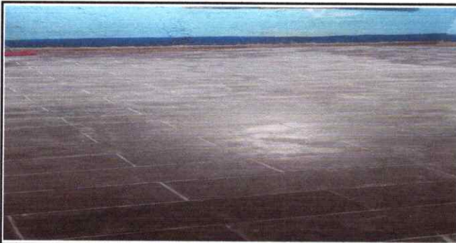
Foto 5: área donde se sustituirá piso cerámico
