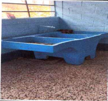
Foto 11: sustitución de pilas
