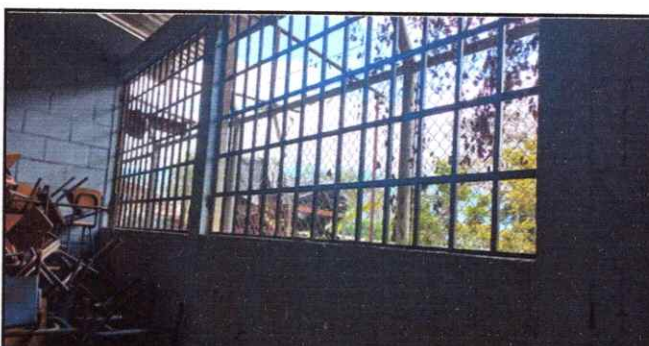
foto 24: Mejoramiento de pared con ventana
