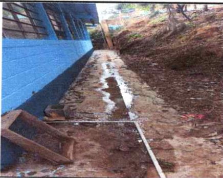
foto 17. Reparación de banquetas de concreto
