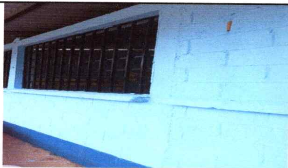
foto 23: Mejoramiento de pared con ventana
