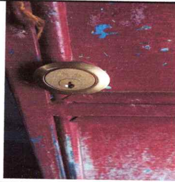
Foto 8: cambio de chapas en las puertas
