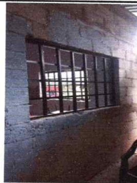
Foto 16: Sustitución de estructura de metal de ventana
