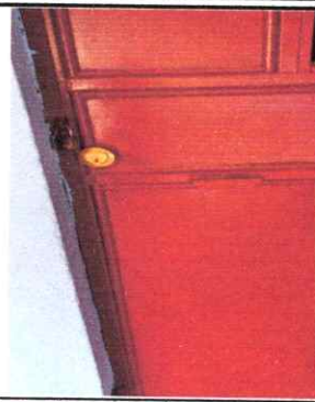
Foto 14: mantenimiento a puerta de metal.
