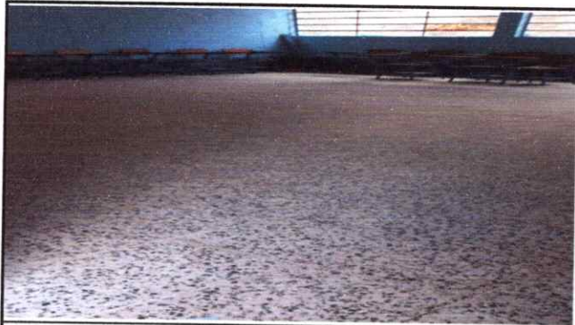
Foto 9: sustitución de torta de concreto por piso de granito.
