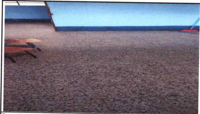
Foto 10: sustitución de torta de concreto por piso de granito
