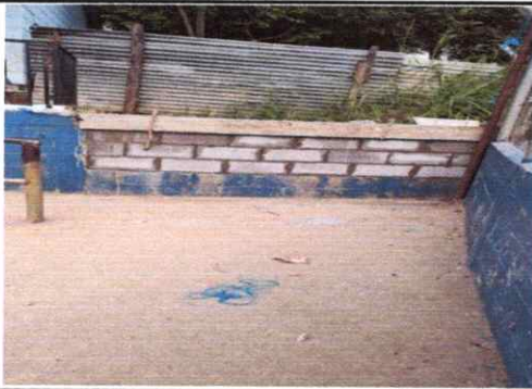
Foto 3: reparación de muro de contención
