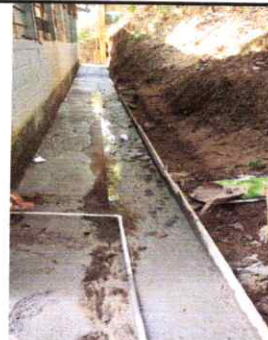
foto 18: Reparación de banquetas de concreto
