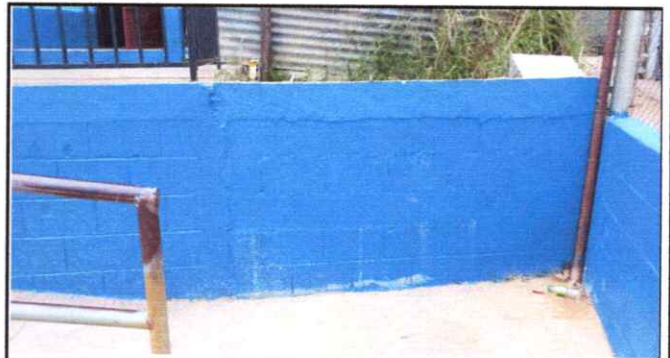
Foto 4: reparación de muro de contención.
