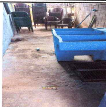
Foto 20: Reparación de piso de torta de concreto
