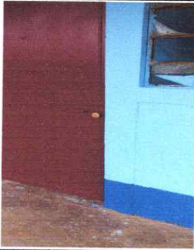
Foto 13: mantenimiento a puerta de metal
