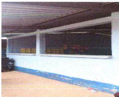
foto 23: Mejoramiento de pared con ventana
