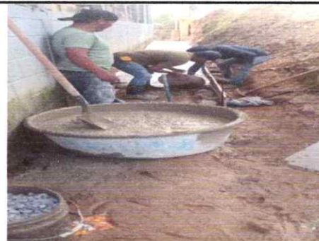
foto 18: Reparación de banquetas de concreto
