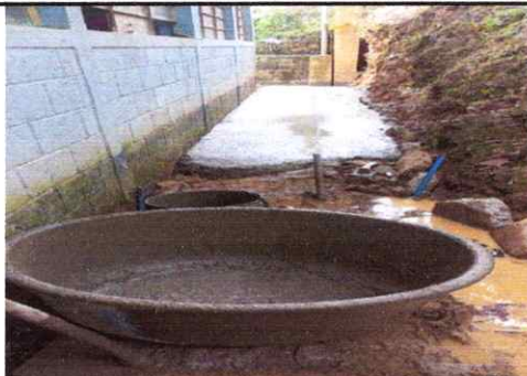
foto 17. Reparación de banquetas de concreto
