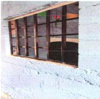
foto 21: Mejoramiento de pared
