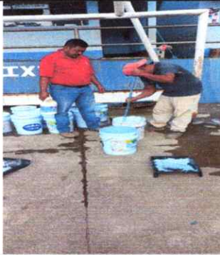
Foto1: Pintura del centro educativo en el exterior
