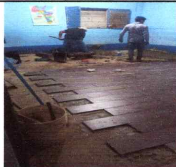
Foto 6: área donde se sustituirá piso cerámico
