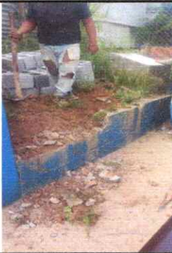
Foto 3: reparación de muro de contención
