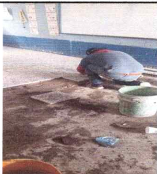
Foto 9: sustitución de torta de concreto por piso de granito.
