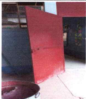
Foto 7: cambio de chapas en las puertas
