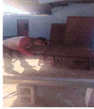
Foto 14: mantenimiento a puerta de metal.
