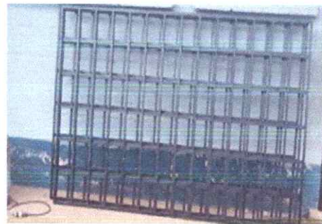
foto 22: mejoramiento de pared
