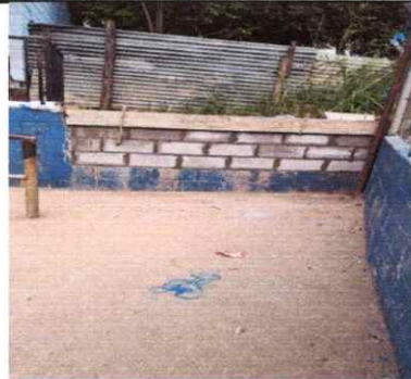
Foto 4: reparación de muro de contención.
