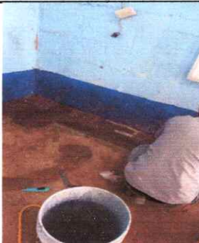
Foto 5: área donde se sustituirá piso cerámico
