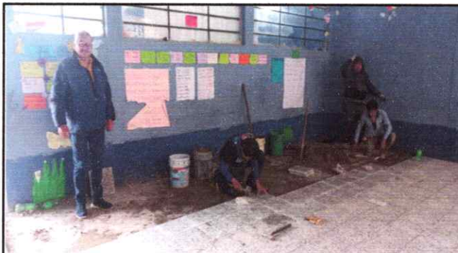
Foto 10: sustitucion de torta de concreto por piso de granito
