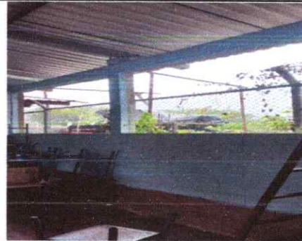
foto 24: Mejoramiento de pared con ventana
