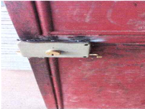
Foto 13: mantenimiento a puerta de metal
