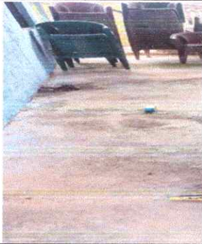
Foto 19: Reparación de piso de torta de concreto
