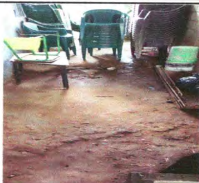
Foto 19: Reparación de piso de torta de concreto
