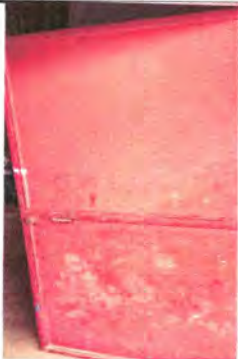
Foto 13: mantenimiento a puerta de metal
