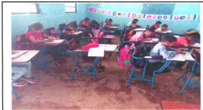
Foto 6: área donde se sustituirá piso cerámico
