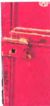
Foto 7: cambio de chapas en las puertas
