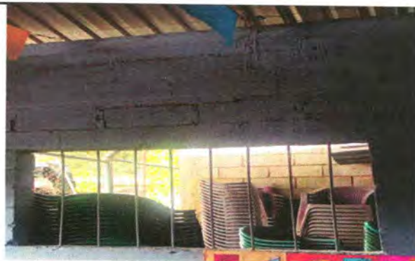
Foto 16: Sustitución de estructura de metal de ventana
