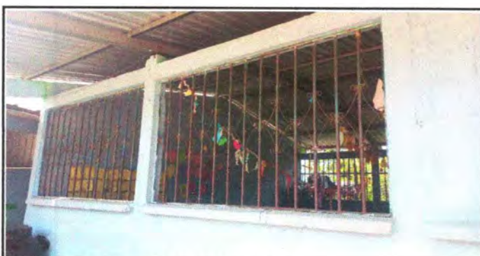
foto 23: Mejoramiento de pared con ventana
