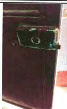
Foto 14: mantenimiento a puerta de metal.
