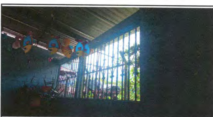
foto 24: Mejoramiento de pared con ventana
