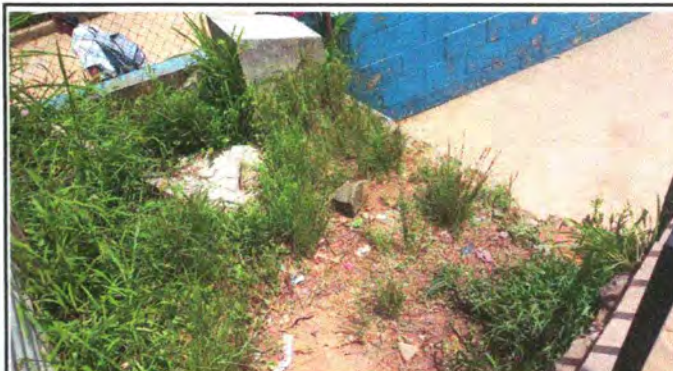
Foto 4: reparación de muro de contención.
