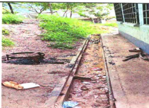
foto 18: Reparación de banquetas de concreto
