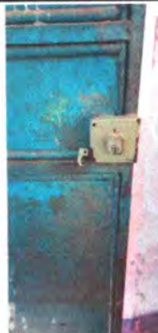
Foto 8: cambio de chapas en las puertas
