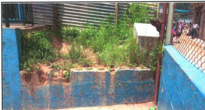
Foto 3: reparación de muro de contención
