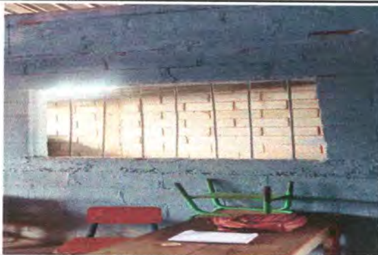
Foto 15: Sustitución de estructura de metal de ventana
