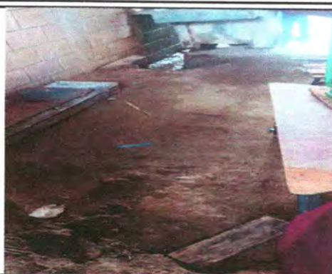
Foto 20: Reparación de piso de torta de concreto
