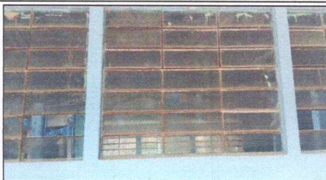
Foto 2: SUSTITUCIÓN DE VIDRIOS
