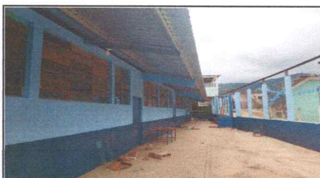
Foto 4: SUSTITUCIÓN DE ESTRUCTURA DE METAL
