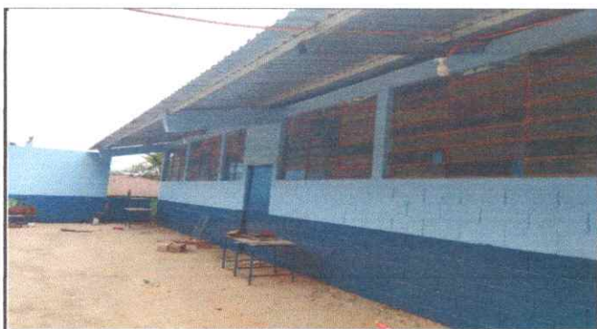
Foto 3: SUSTITUCIÓN Y REPARACIÓN DE CABLEADO E INTALCIÓN ELÉCTRICA
