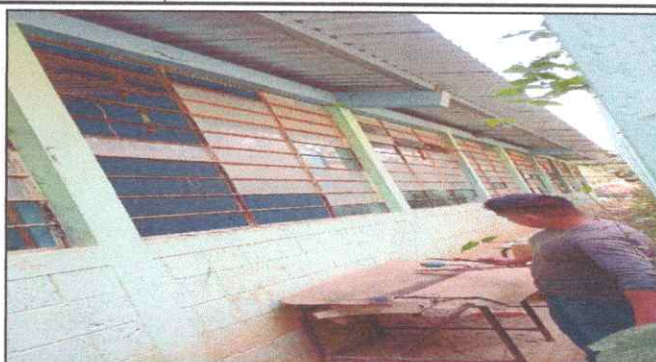
Foto 2: SUSTITUCIÓN DE VIDRIOS
