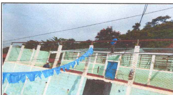
Foto 4: SUSTITUCIÓN DE ESTRUCTURA DE METAL
