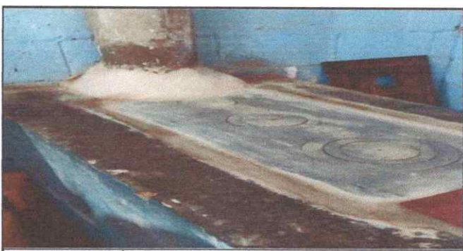
Foto 6: REPARACIÓN DE ESTUFA RURAL
