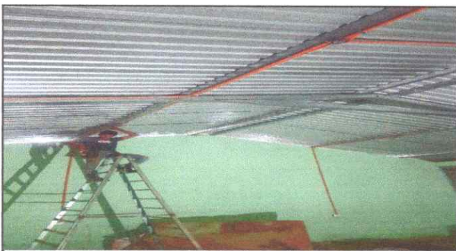
Foto 3: SUSTITUCIÓN Y REPARACIÓN DE CABLEADO E INTALACIÓN ELÉCTRICA
