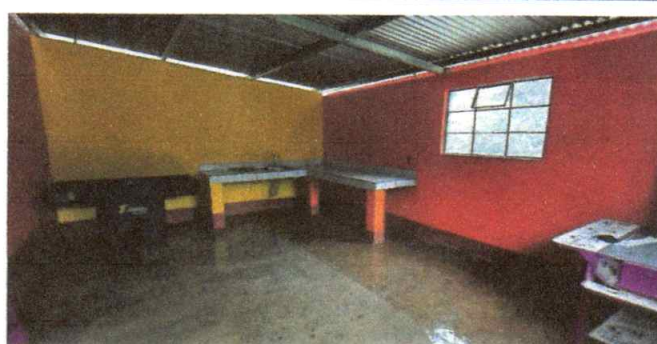
Foto 4: Repello en muros de cocina terminado.
