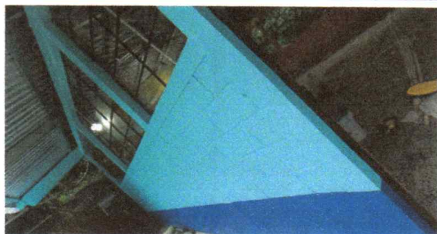
Foto 5: Pintura en paredes de aula terminado
