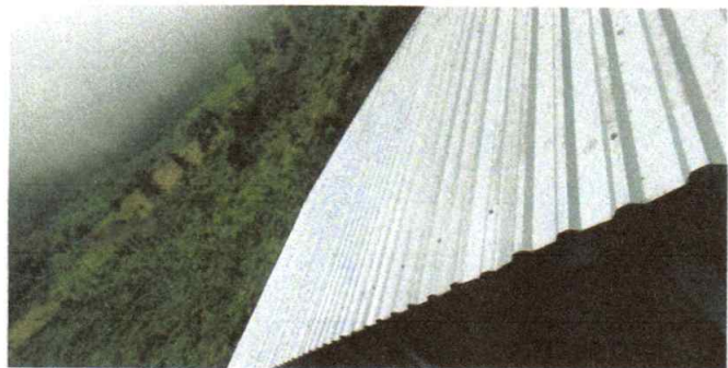
Foto1: Sustitución de lámina terminado
