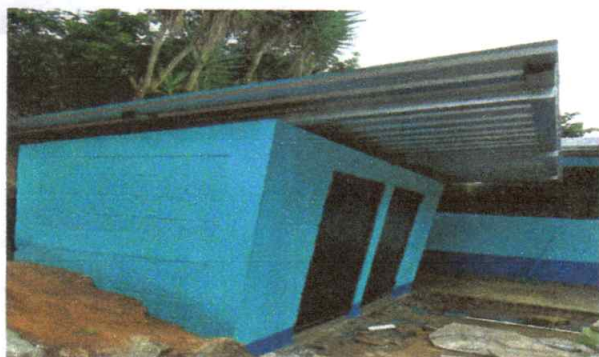
Foto 3: Mejoramiento en paredes en baños terminado.
