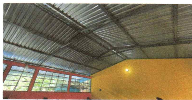
Foto 2: Sustitución de estructura de soporte de techo terminado
