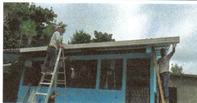
Foto 6: Intslación de canal de PVC para bajadas de agua pluvial
