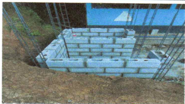
Foto 3: Mejoramiento en paredes en baños.
