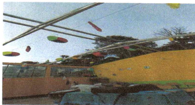
Foto 2: Instalación de estructura de soporte de metal
