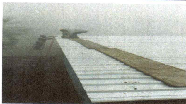
Foto1: Instalación de lámina.
