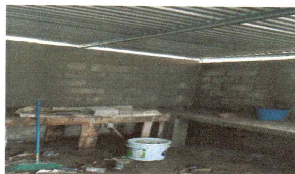
Foto 4: Repello en muros de cocina
