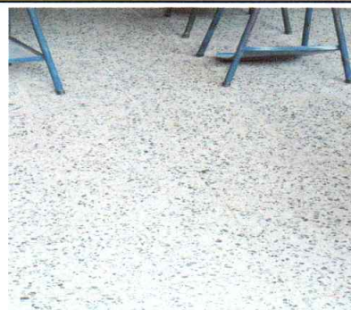
Foto 6: Sustitución de torta de cemento por piso de granito en aula
