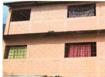
Foto 2: Mejoramiento de balcones de metal
