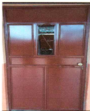
Foto 3: Mejoramiento y mantenimiento de puertas de aulas (chapa, lámina, bisagra, lijado y pintura).
