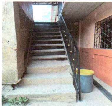
Foto 1: Mejoramiento de baranda y tapaderas para de metal
