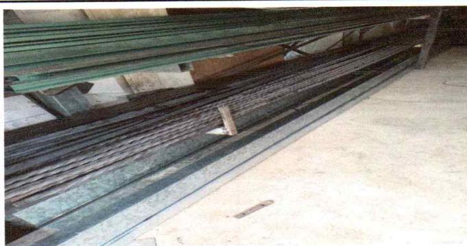
Foto1: Mejoramiento de baranda y tapaderas para de metal
