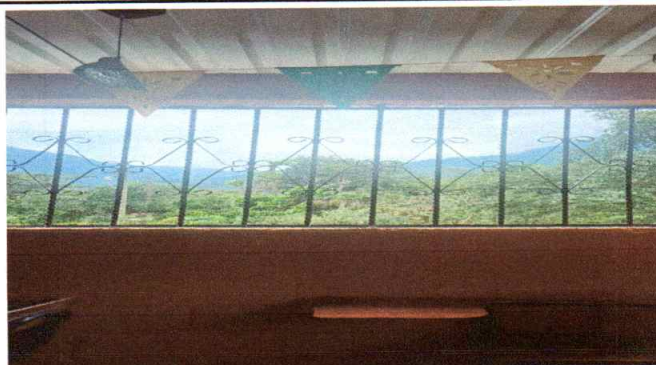
Foto 2: Mejoramiento de balcones de metal
