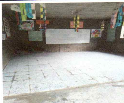
Foto 6: Sustitución de torta de cemento por piso de granito en aula
