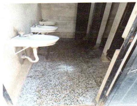
Foto 4: Sustitución de torta de cemento por piso de granito en baño
