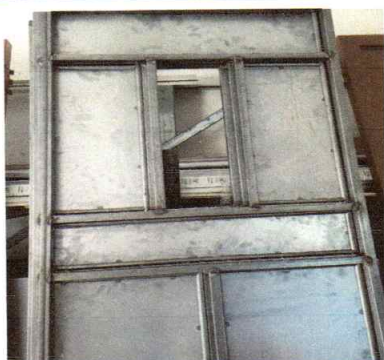
Foto 3: Mejoramiento y mantenimiento de puertas de aulas (chapa, lámina, bisagra, lijado y pintura).
