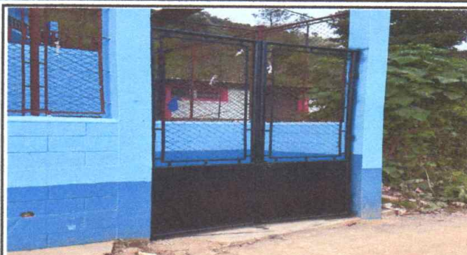
Foto 8: MANTENIMIENTO DE PORTONES PRINCIPALES
