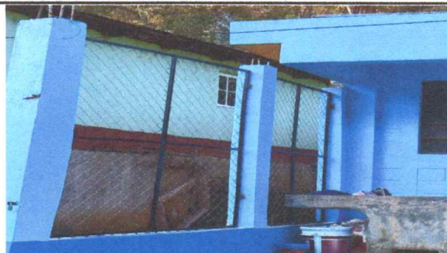
Foto 11 REPARACION DE MALLA POR BARANDA PERIMETRAL DE MALLA
