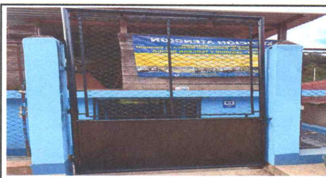
Foto 10 MANTENIMIENTO DE PORTONES PRINCIPALES
