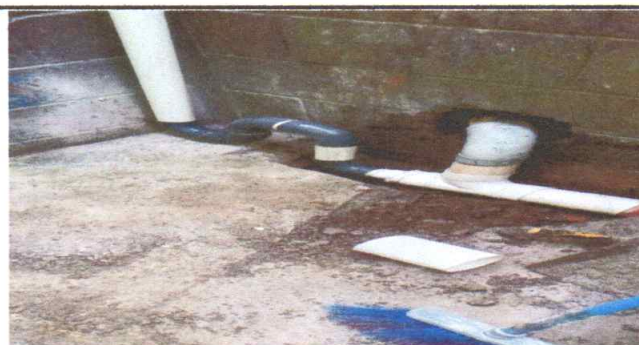
Foto 4 REPARACION DE TUBERIA DE DRENAJE BAÑOS Y PILA
