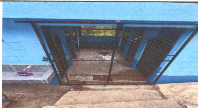
Foto 7: MANTENIMIENTO A PORTON DE BAÑO
