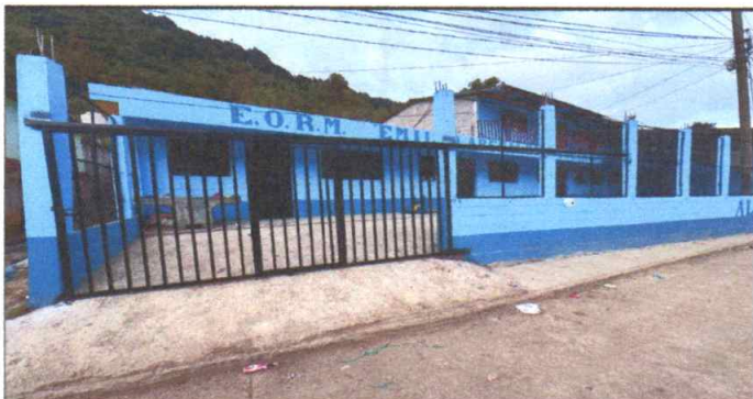
Foto 9 MANTENIMIENTO DE PORTONES PRINCIPALES
