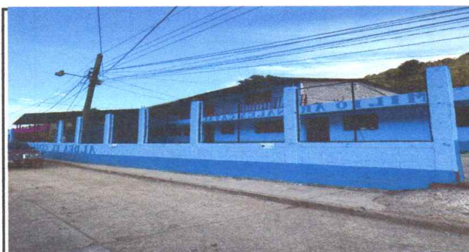
Foto 6 APLICACIÓN DE PINTURA EN MUROS EXTERIORES E INTERIORES
