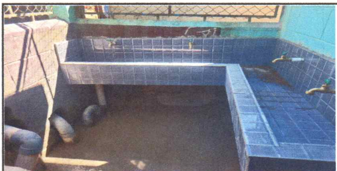
Foto 3: MEJORAMIENTO DE MULTILAVAMANOS
