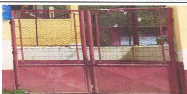
Foto 8: MANTENIMIENTO DE PORTONES PRINCIPALES
