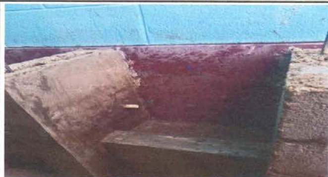
Foto1: MEJORAMIENTO DE MINGITORIOS
