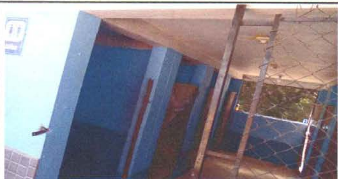
Foto 7: MANTENIMIENTO A PORTON DE BAÑO
