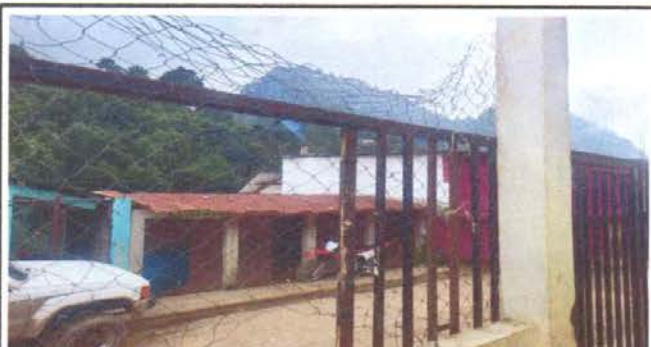
Foto 10 MANTENIMIENTO DE PORTONES PRINCIPALES
