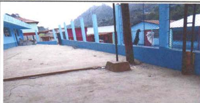
Foto 12 REPARACION DE MALLA POR BARANDA PERIMETRAL DE MALLA
