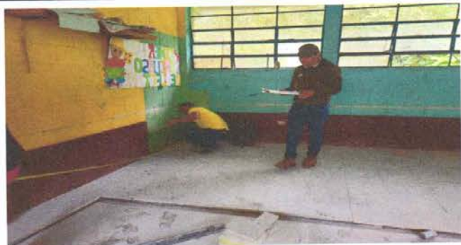
Foto 13 SUSTITUCION DE TORTA DE CEMENTO POR PISO DE GRANITO
