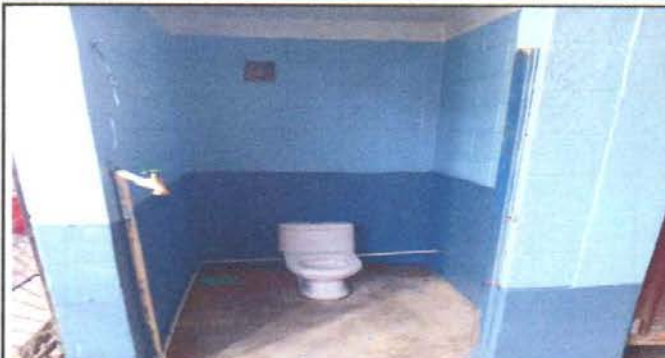
Foto 2: MEJORAMIENTO DE MINGITORIOS
