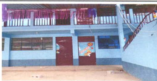
Foto 9 MANTENIMIENTO DE PORTONES PRINCIPALES
