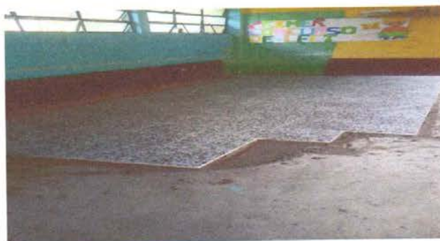
Foto 14 SUSTITUCION DE TORTA DE CEMENTO POR PISO DE GRANITO
