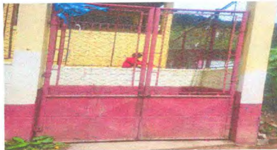
Foto 8: MANTENIMIENTO DE PORTONES PRINCIPALES
