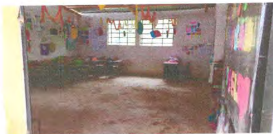
Foto 13 SUSTITUCION DE TORTA DE CEMENTO POR PISO DE GRANITO
