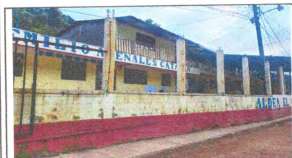
Foto 5 APLICACIÓN DE PINTURA EN MUROS EXTERIORES E INTERIORES
