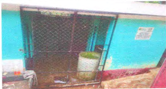
Foto 7: MANTENIMIENTO A PORTON DE BAÑO
