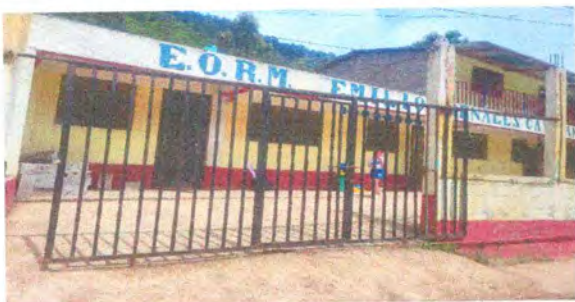
Foto 9 MANTENIMIENTO DE PORTONES PRINCIPALES
