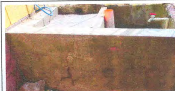
Foto 4 REPARACION DE TUBERIA DE DRENAJE BAÑOS Y PILA
