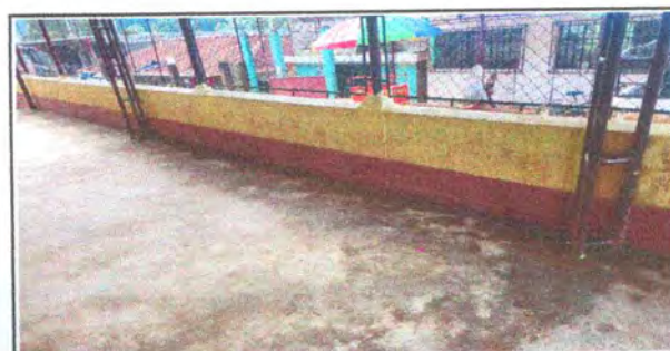
Foto 6 APLICACIÓN DE PINTURA EN MUROS EXTERIORES E INTERIORES
