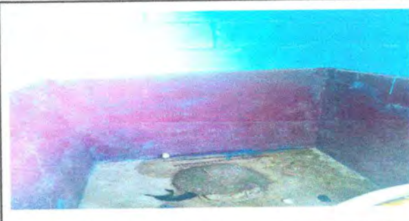
Foto 2: MEJORAMIENTO DE MINGITORIOS
