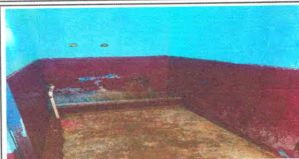
Foto1: MEJORAMIENTO DE MINGITORIOS
