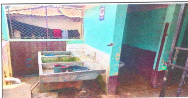
Foto 3: MEJORAMIENTO DE MULTILAVAMANOS
