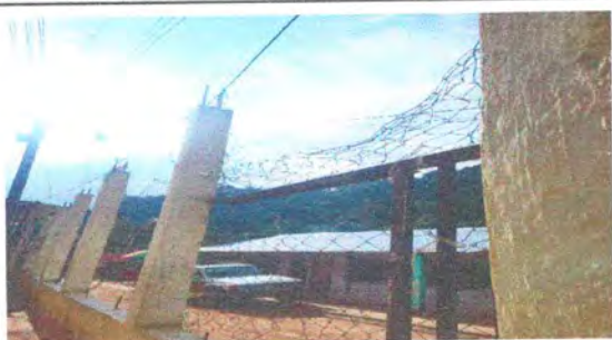
Foto 11 REPARACION DE MALLA POR BARANDA PERIMETRAL DE MALLA
