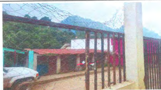
Foto 12 REPARACION DE MALLA POR BARANDA PERIMETRAL DE MALLA
