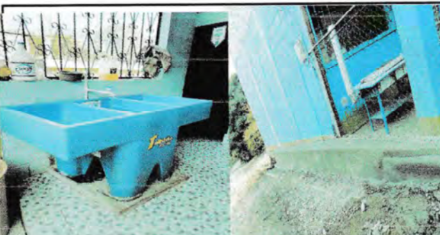
Foto 6: Sustitución de pila y reparación de banqueta.
