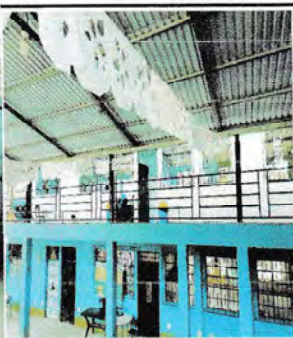
Foto 3: Sustitución de portón de ingreso y sustitución de malla por baranda de metal
