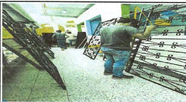
Foto 5: Sustitución de balcones metal.
