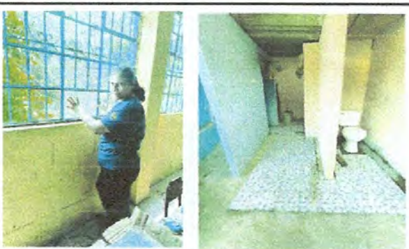
Foto 4: Sustitución de vidrios y sustitución de inodoros.
