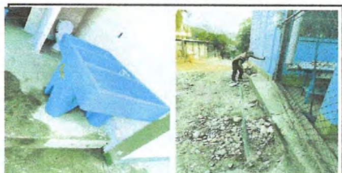
Foto 6: Sustitución de pila y reparación de banqueta.
