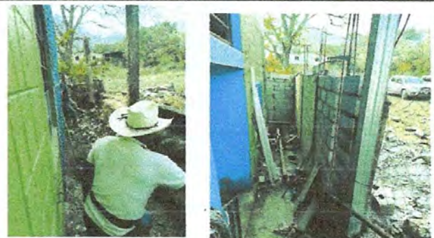
Foto 2: Reparación de muro perimetral.
