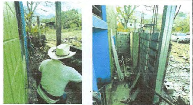
Foto 2: Reparación de muro perimetral.
