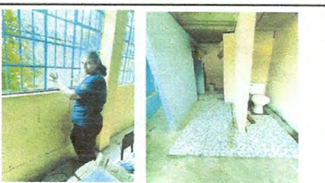
Foto 4: Sustitución de vidrios y sustitución de inodoros.
