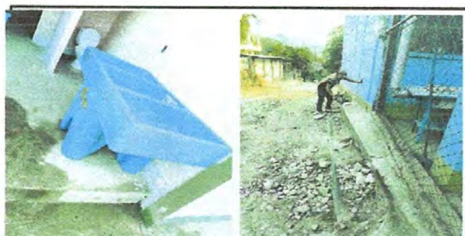
Foto 6: Sustitución de pila y reparación de banqueta.
