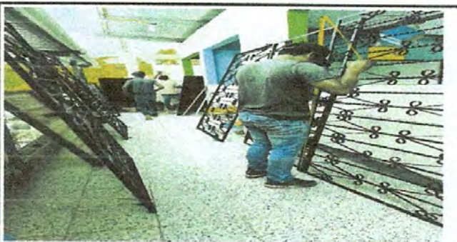
Foto 5: Sustitución de balcones metal.
