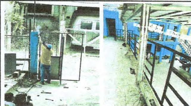
Foto 3: Sustitución de portón de ingreso y sustitución de malla por baranda de metal
