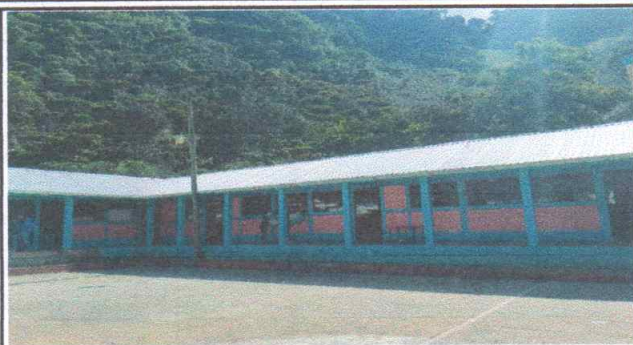
Foto1: Cubierta de lamina
