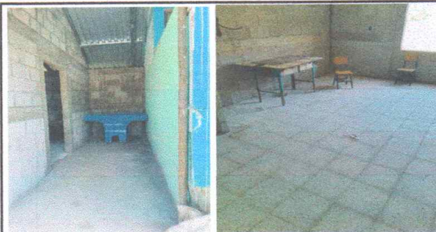
Foto 2: Reparación de cocina y piso
