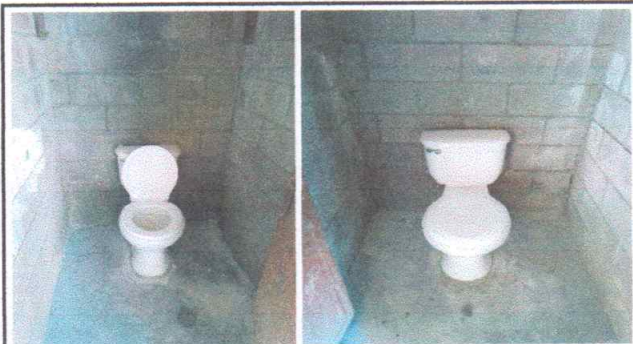
Foto 3: Servicios sanitario y sus accesorios
