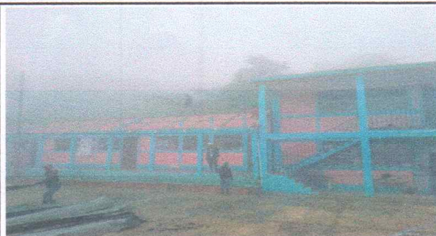
Foto 1: Cubierta de lamina
