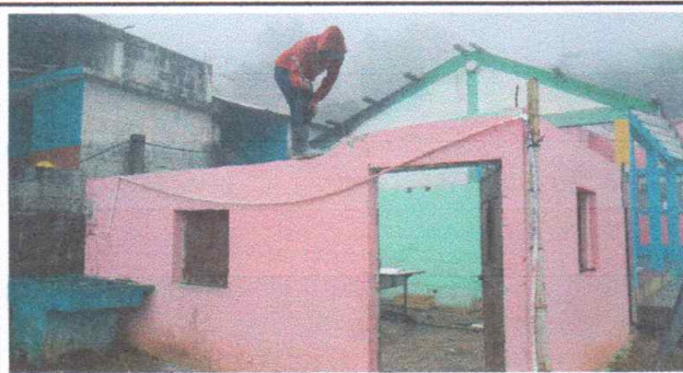
Foto 2: Reparación de cocina y piso
