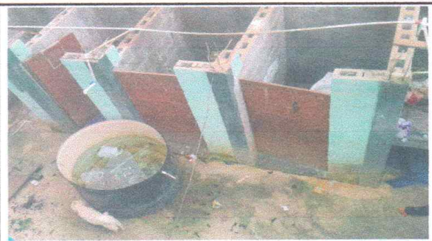
Foto 4: Red de agua potable. Reparacion y mantenimiento de sisternas/depositos de agua
