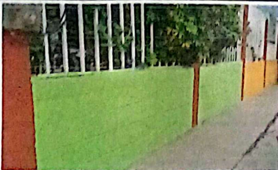
Foto 5: Aplicación de pintura en circulación de la escuela
