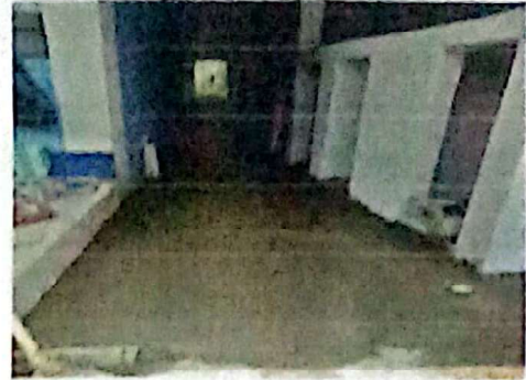
Foto 2: Fundición de la torta de concreto
