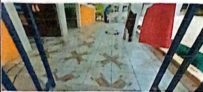
Foto 3: Instalación de cerámica
