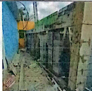
Foto 2: Construcción de sanitarios
