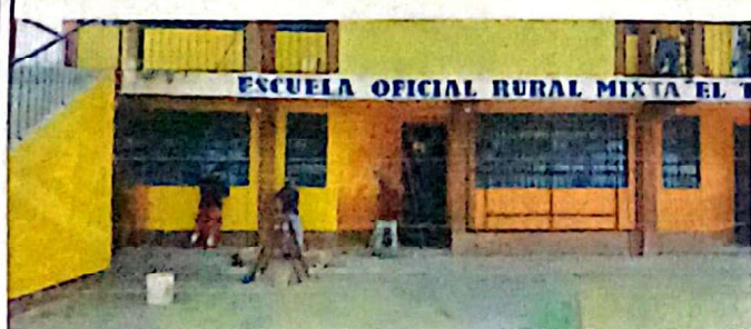
Foto 5: Aplicación de pintura de la escuela
