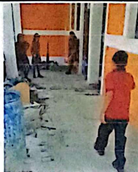
Foto 4: Limpieza del corredor antes de la instalación de piso cerámico
