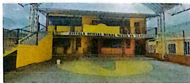
Foto 6: Aplicación de pintura a la escuela
