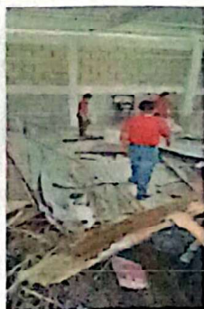
Foto 3: Limpieza para la colocación de piso
