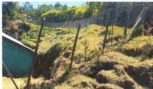
Foto 1: Reparación de muro perimetral
