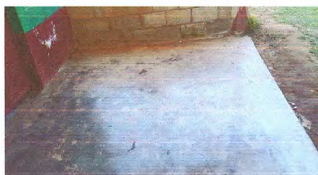
Foto 2: Sustitución de piso de torta de concreto
