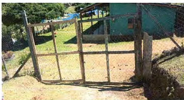
Foto 4: Sustitución de porton principal de la escuela
