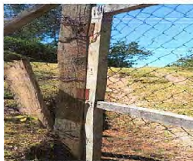
Foto 6: Sustitución de porton principal de la escuela
