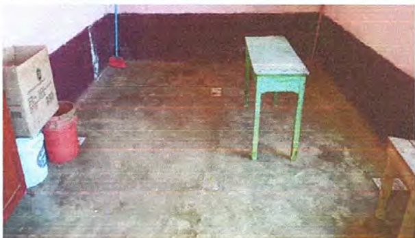
Foto 1: Sustitución de piso de torta de concreto
