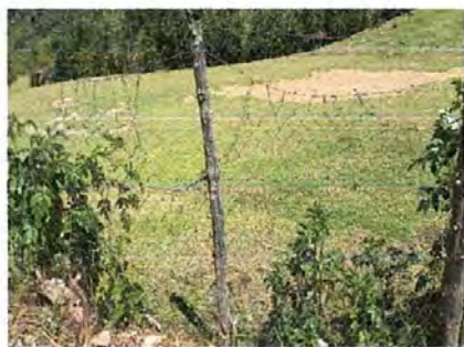
Foto 3: Reparación de muro perimetral
