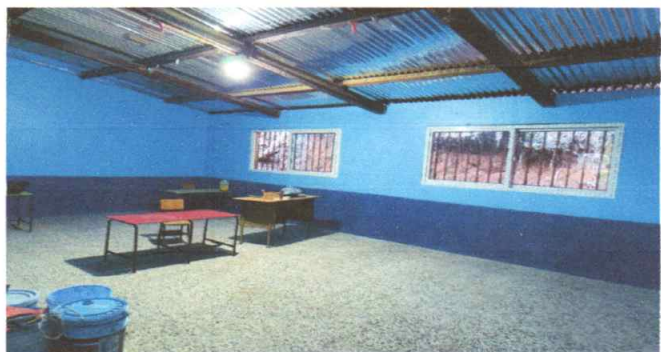
Foto: 9 sustitución piso de granito
