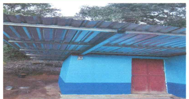
Foto 11: sustitución de flipón
