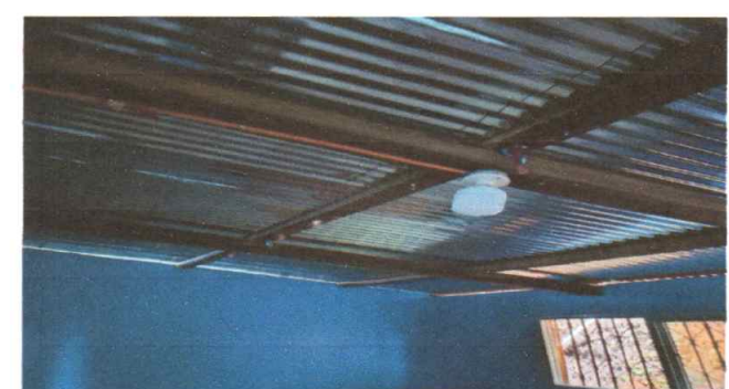
Foto 10: sustitucion de plafoneras
