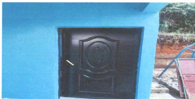
Foto1: SUSTITUCION DE PUERTAS
