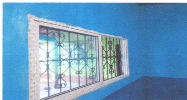
Foto 4: sustitución de ventanales
