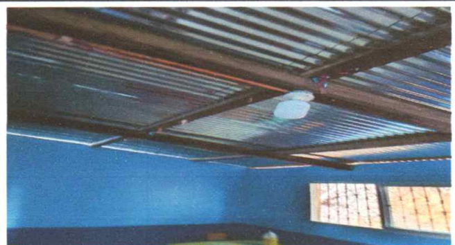
Foto 5: sustitución de cableado electrico
