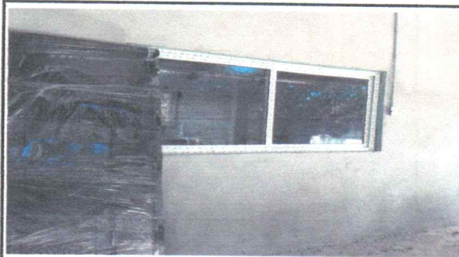
Foto 4: sustitución de ventanales
