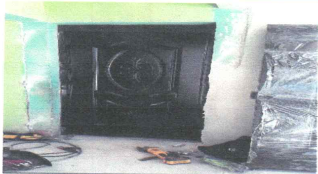
Foto 1: SUSTITUCION DE PUERTAS
