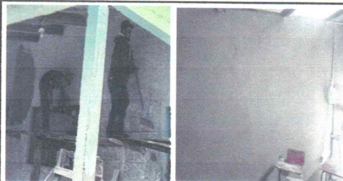
Foto 6: sustitucion de repello
