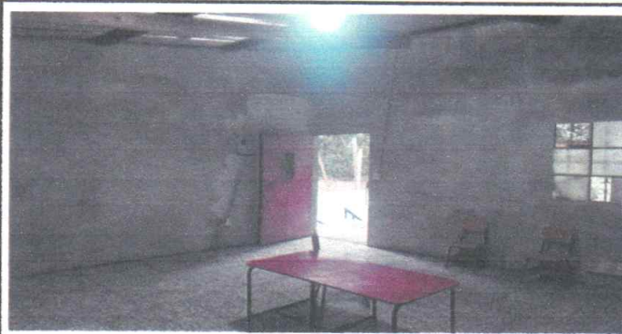
Foto 8: sustitución piso de torta de concreto
