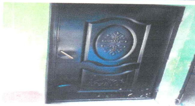
Foto 2: sustitucion de puertas
