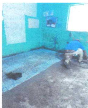
Foto: 9 sustitución piso de granito
