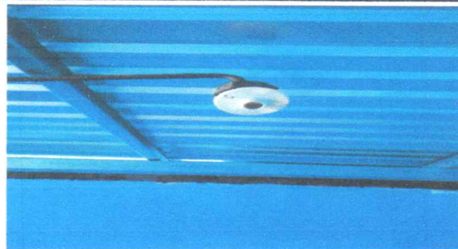
Foto 10: sustitucion de plafoneras
