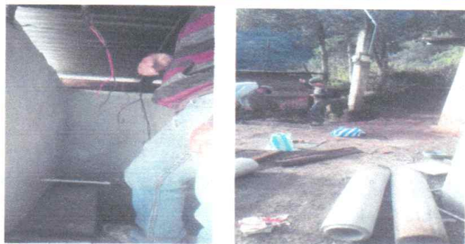
Foto 5: sustitución de cableado electricoG
