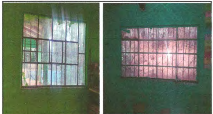
Foto 4: sustitución de ventanales
