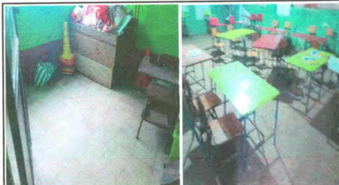
Foto: 9 sustitución piso de granito
