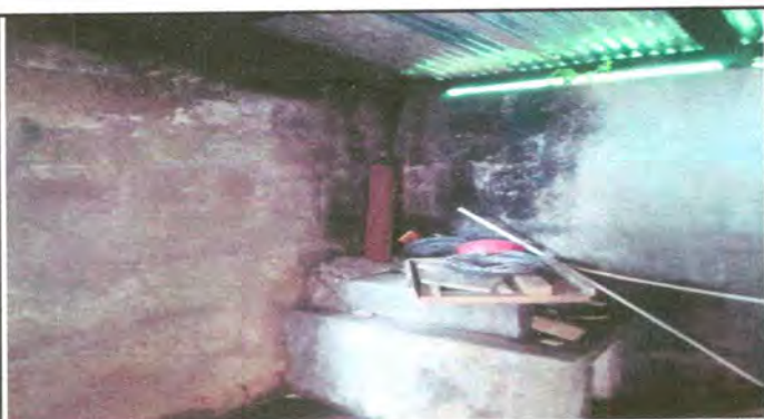
Foto: 15 sustitución de plancha y chimenea de concreto
