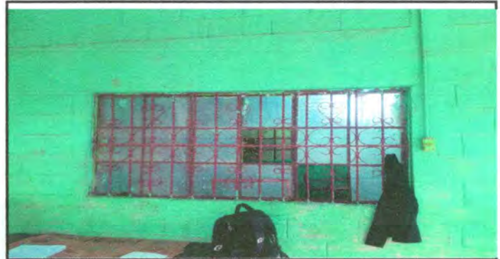
Foto 6: sustitución de balcones de metal
