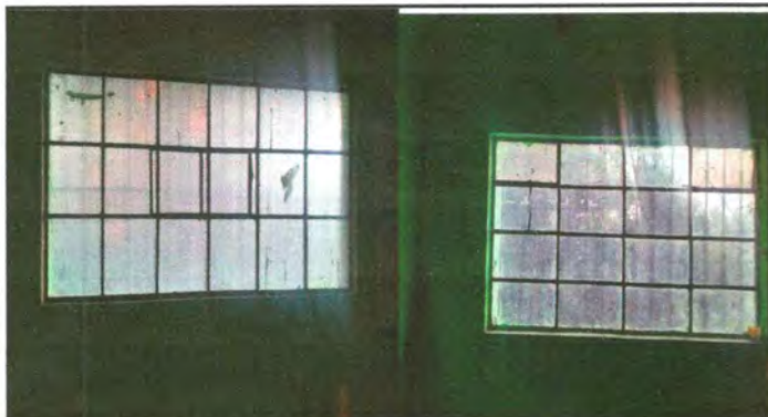
Foto 3: sustitución de ventanales
