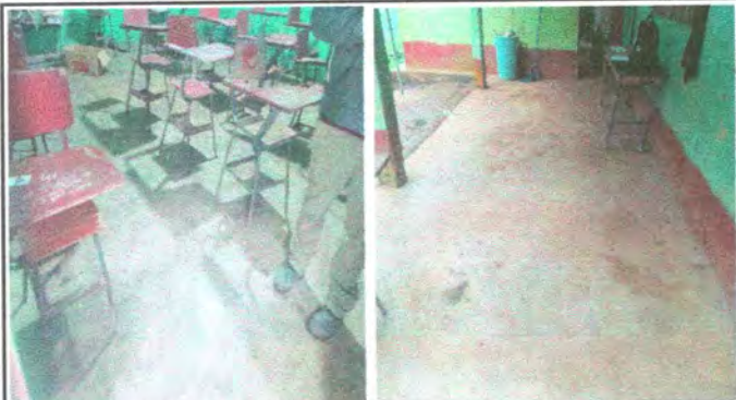
Foto7: sustitución piso de torta de concreto
