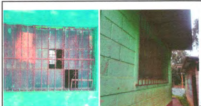
Foto 5: sustitucion de balcones de metal
