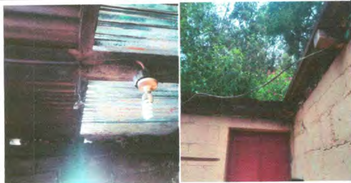
Foto13: sustitución de cableado electrico
