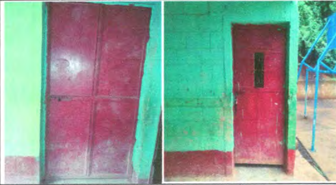
Foto1: SUSTITUCION DE PUERTAS
