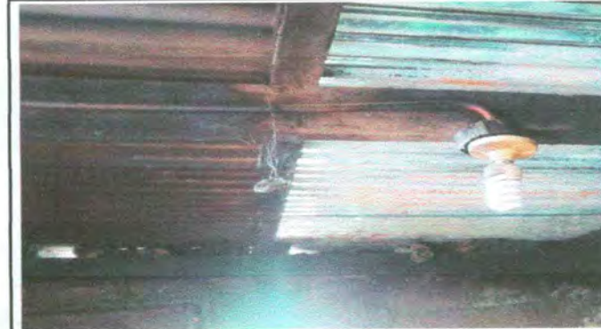
Foto 10: sustitucion de plafoneras
