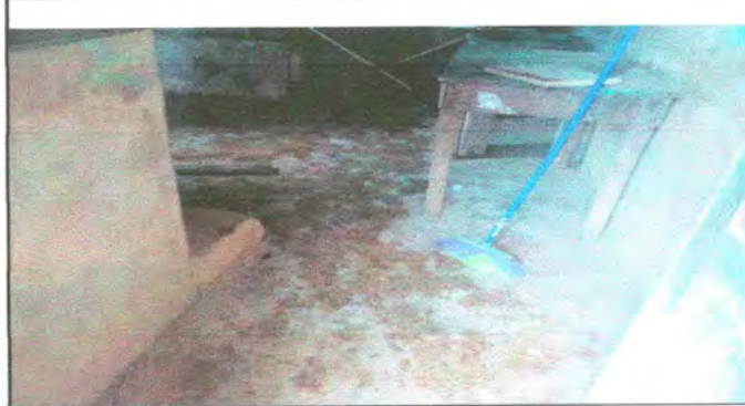
Foto 8: sustitución piso de torta de concreto
