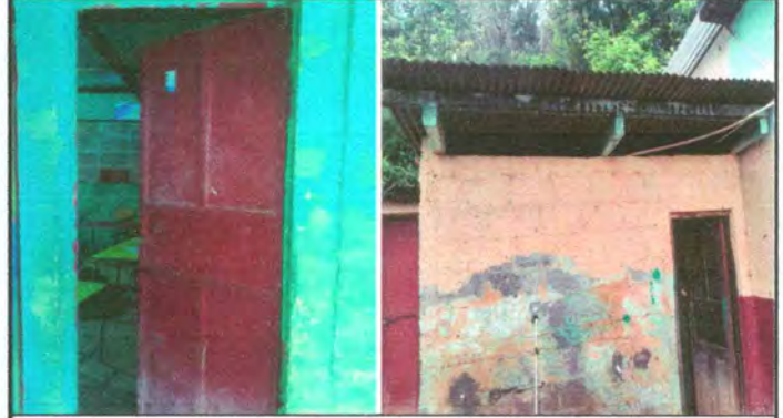
Foto 2: sustitucion de puertas
