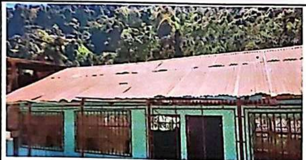
Foto 3: SUSTITUCION DE LAMINA
