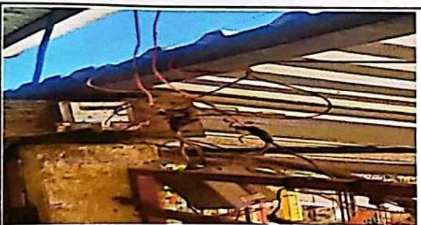
Foto 5: SUSTITUCION DE CABLEADO SISTEMA ELECTRICO
