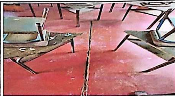
Foto 2: CAMBIO DE PISO
