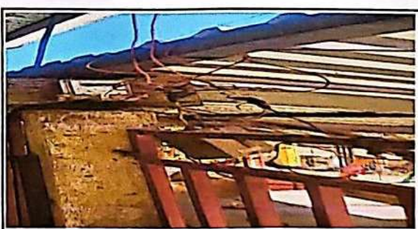
Foto 6: SUSTITUCION DE CABLEADO SISTEMA ELECTRICO
