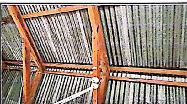
Foto 4: SUSTITUCION DE ESTRUCTURA DE SOPORTE
