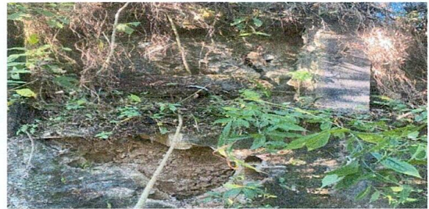
Foto 4: Muro de Contención (antes)
