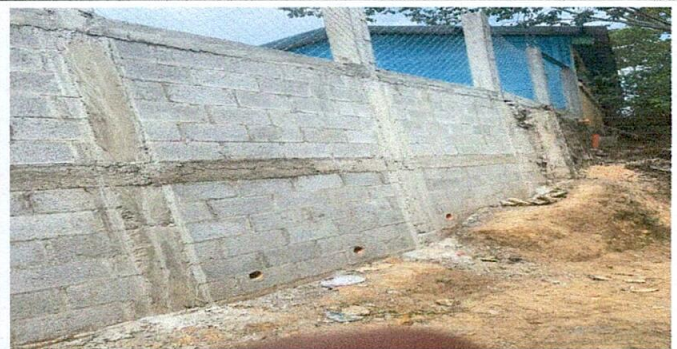
Foto 6: Muro de contención (despues)
