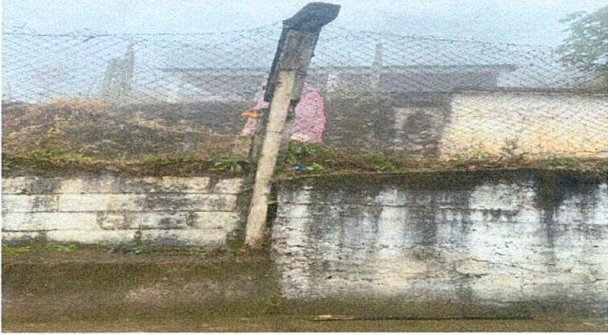
Foto1: Columnas de Muro perimetral (antes)
