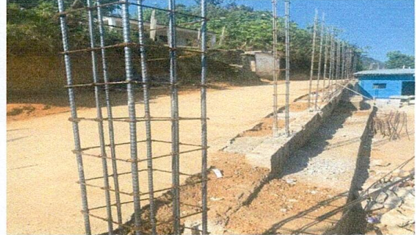
Foto 2: Columnas de Muro perimetral (durante)
