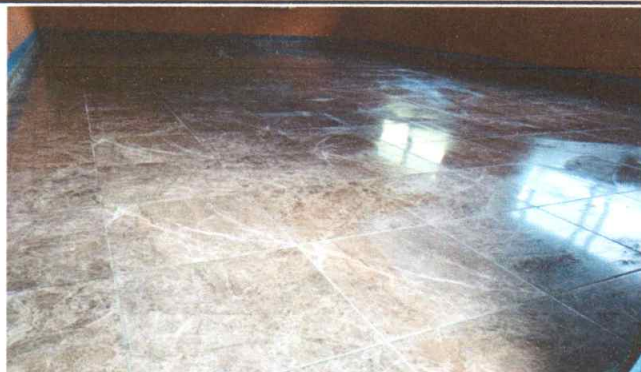
Foto 4: Sustitución de piso.
