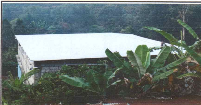
Foto 1: Sustitución de lámina.
