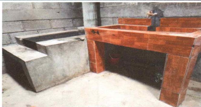
Foto 5: Sustitución de plancha.
