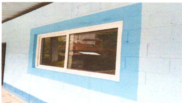
Foto 3: Sustitución de ventanas y vidrio
