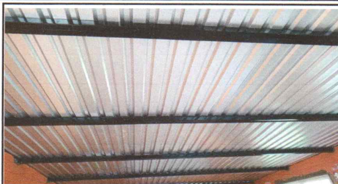
Foto 2: Sustitución de estructura de soporte de techo
