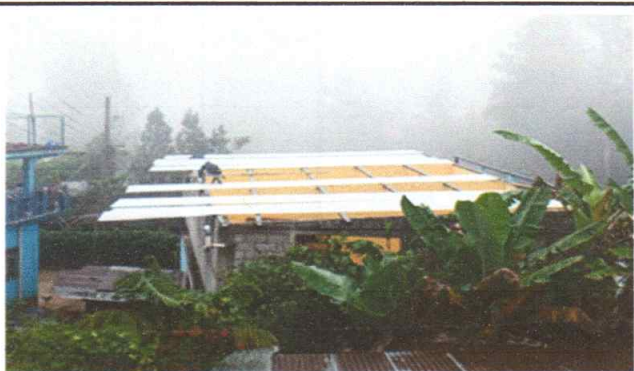
Foto 1: Sustitución de lámina.
