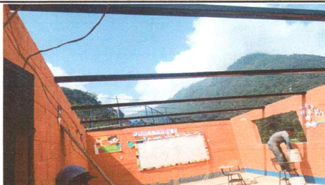
Foto 2: Sustitución de estructura de soporte de techo
