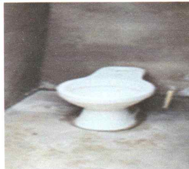
Foto 6: Sustitución de sanitario
