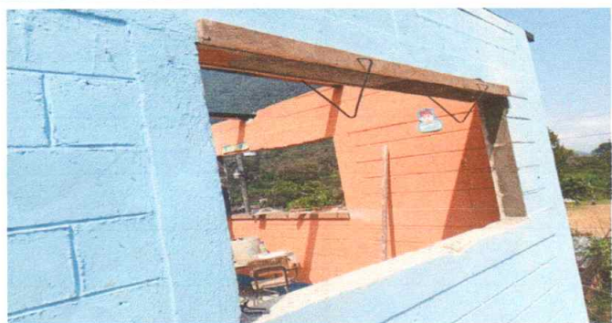
Foto 3: Sustitución de ventanas y vidrio
