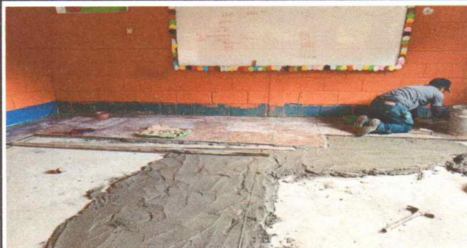
Foto 4: Sustitución de piso.
