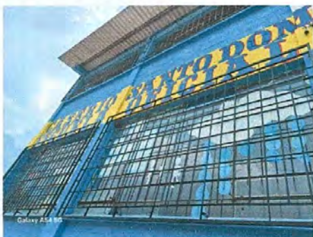
Foto 9: Mantenimiento de balcones de metal
