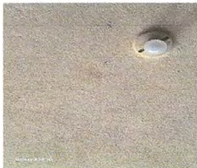
Foto 7: Sustitución de focos ahorradores
