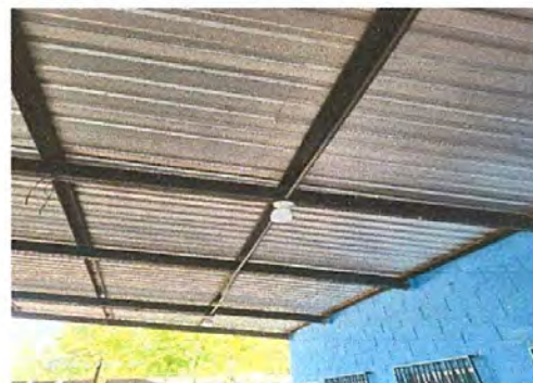
Foto 10: Sustitución de cableado eléctrico
