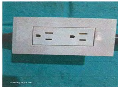
Foto 8: Sustitución de tomacorrientes dobles
