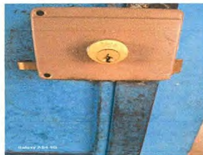
Foto 12: Sustitución de chapa
