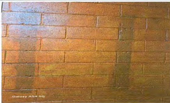
Foto 15: Pintura en muros exteriores e interiores
