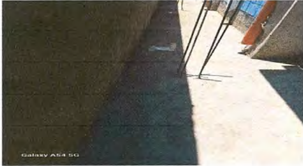
Foto 13: Sustitución de piso de torta de concreto
