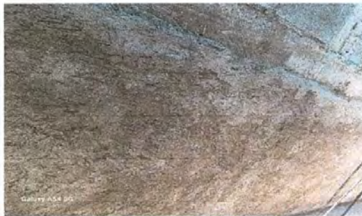
Foto 17: Aplicación de repello de muro de contención
