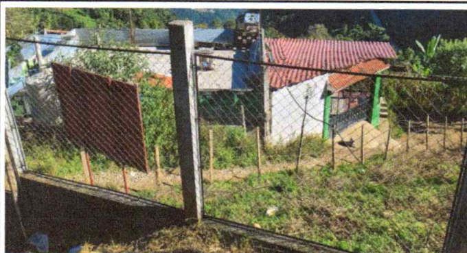
Foto 10: reparación muro perimetral
