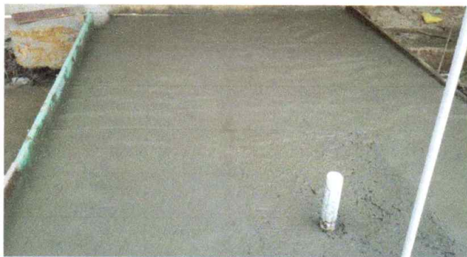
Foto 7: reparación de losa de concreto de patio
