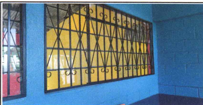
Foto 11: sustitución de vidrios y mejoramiento de ventanas con balcones
