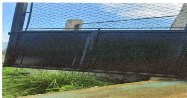
Foto 12: instalación de chapa a portón, lijado y pintado
