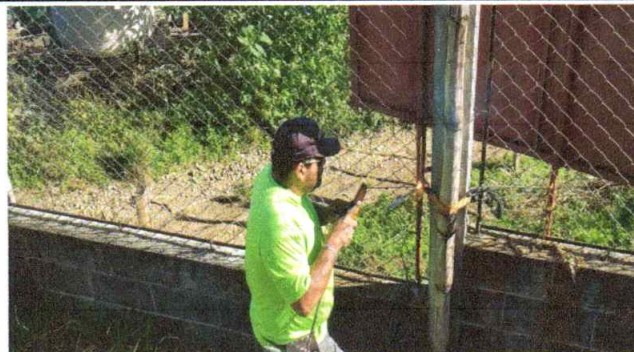
Foto 10: reparación muro perimetral
