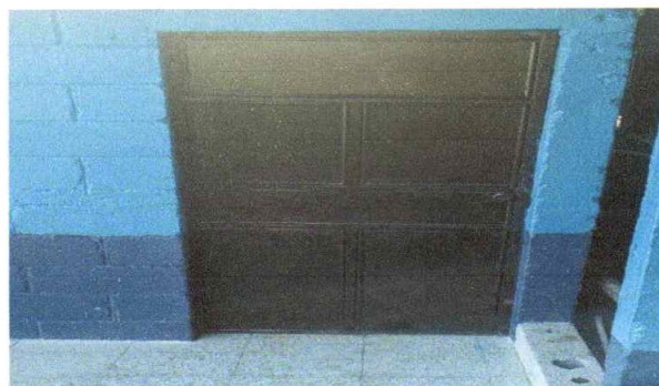
Foto 8: Mantenimiento de puerta de cocina y cambio de chapa
