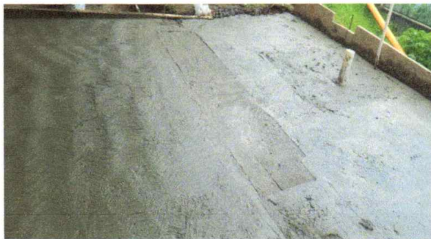
Foto 7: reparación de losa de concreto de patio
