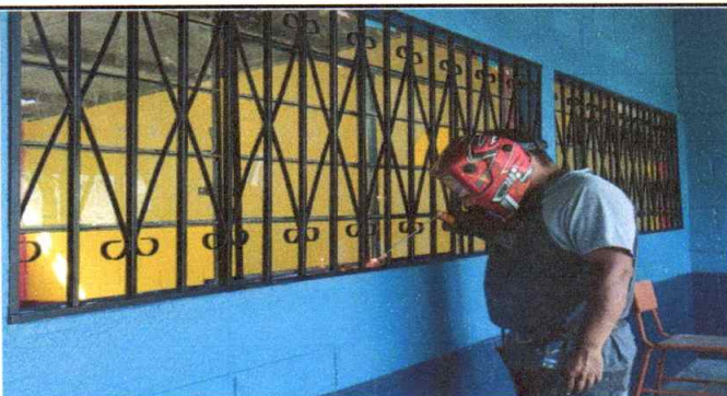
Foto 11: sustitución de vidrios y mejoramiento de ventanas con balcones
